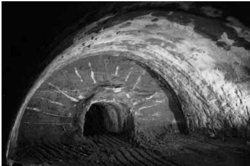
Fig. 1.14. Inyecciones desde un túnel piloto.
