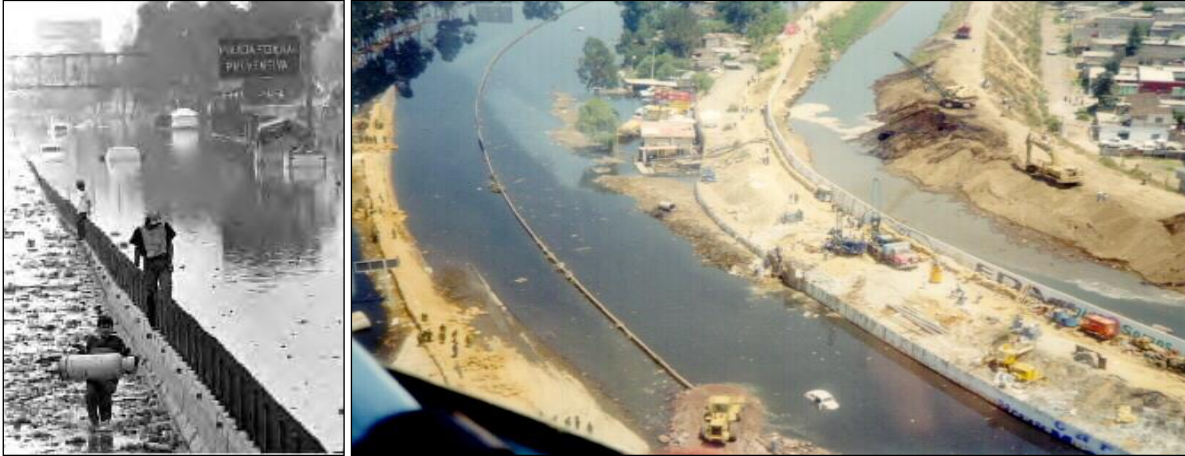
Fig. 1.10. Fallas en los bordos y afectaciones a la población.
