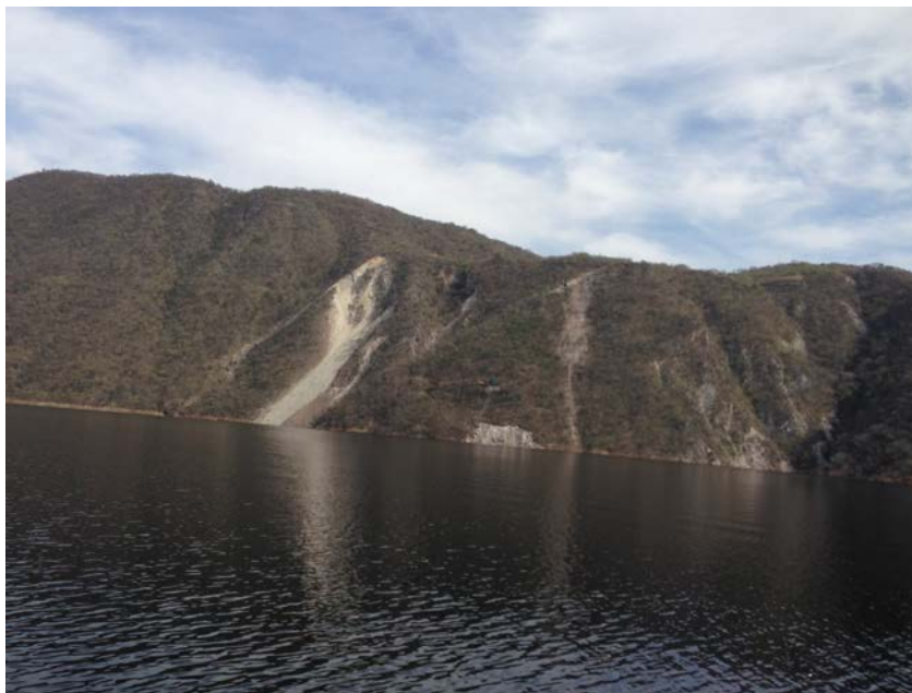
Fig 64. Falla circular margen izquierda presentada en talud aguas arriba de la presa La Yesca (Palos Verdes).
