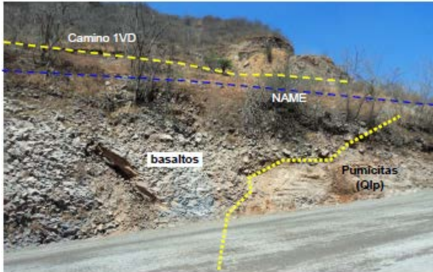
Fig 51. 3+000 a la 3+050. Se observa el camino por encima, el NAME se encuentra dos metros por debajo del camino de acceso. Información proporcionada por el Depto Geología GEIC.
