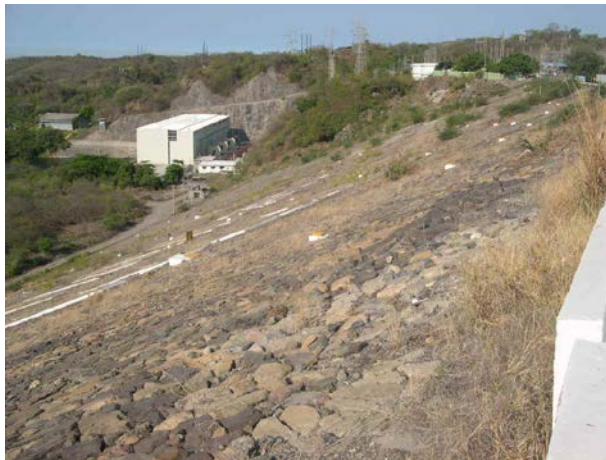
Fig 10. Casa de máquinas exterior de la CH La Villita, Mich.
