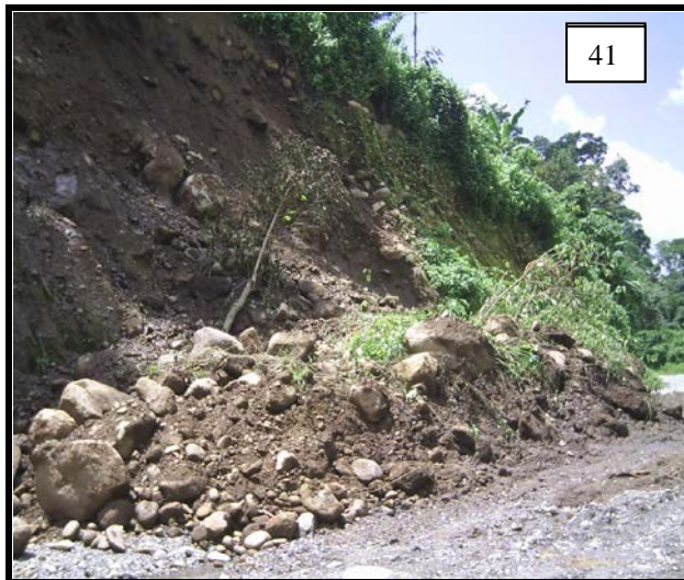
Fig 41-42. (41) La longitud aproximada del deslave es de aproximadamente 30 metros. (42) Erosión del camino hacia la presa derivadora.
