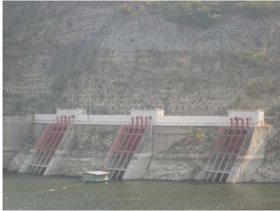
Fig 9. Se observa la obra de toma de la CH Infiernillo, Mich.
