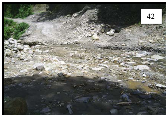
Fig 41-42. (41) La longitud aproximada del deslave es de aproximadamente 30 metros. (42) Erosión del camino hacia la presa derivadora.
