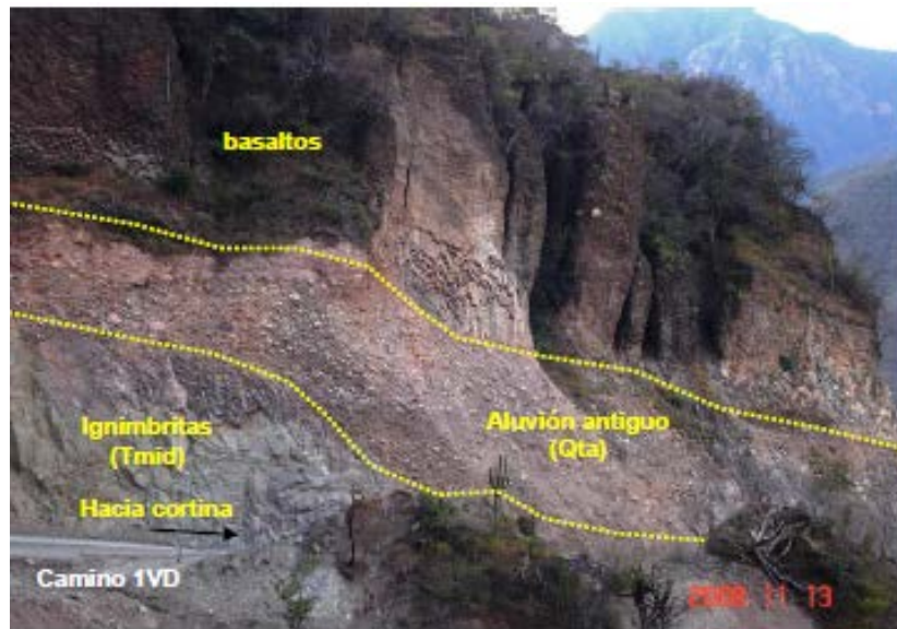
Fig 50. Camino acceso 2+150 a la 2+250. Geología proporcionada por el Departamento de Geología de la GEIC.
