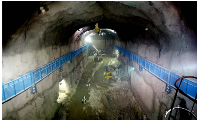
Fig 11. Casa de máquinas interior de la PH La Yesca dentro de la ladera derecha.
