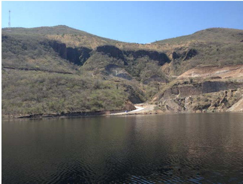
Fig 62. Fotografía de la zona depresión socavón donde se realizaron los análisis de las dos secciones críticas.
