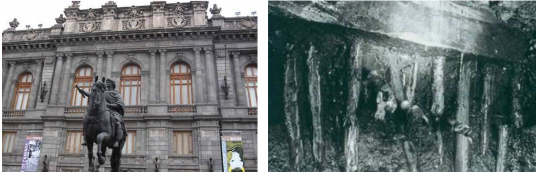
Figura 3.4 Palacio de minería y su cimentación (Auvinet y Rodríguez, 2006)
