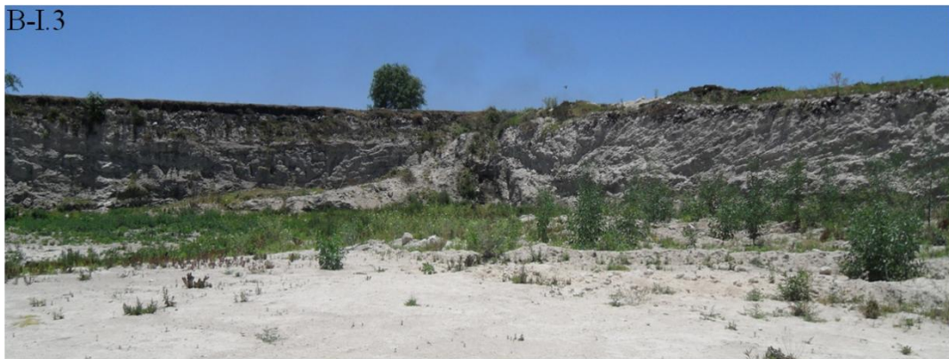
FIG. 35 Paredes Sur y Occidente
