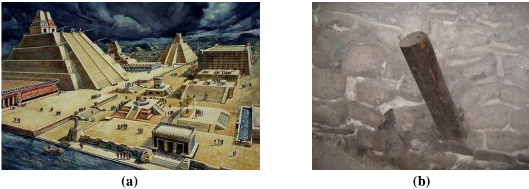
Figura 2.1. (a) Configuración general de la ciudad de Tenochtitlán (b) Pilotes de madera del Templo Mayor, de la ciudad de México [Jaime, 1997]
