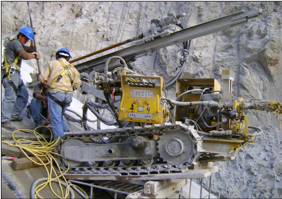
Fotografía 6.4. Equipo de perforación y plataforma utilizada para realizar los barrenos de inyección en el Plinto Margen Derecha.
