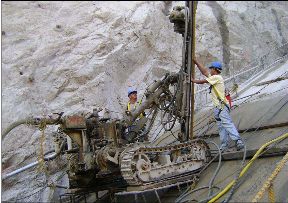
Fotografía 6.3. Equipo de perforación y plataforma utilizada para realizar los barrenos de inyección en el Plinto Margen izquierda.
