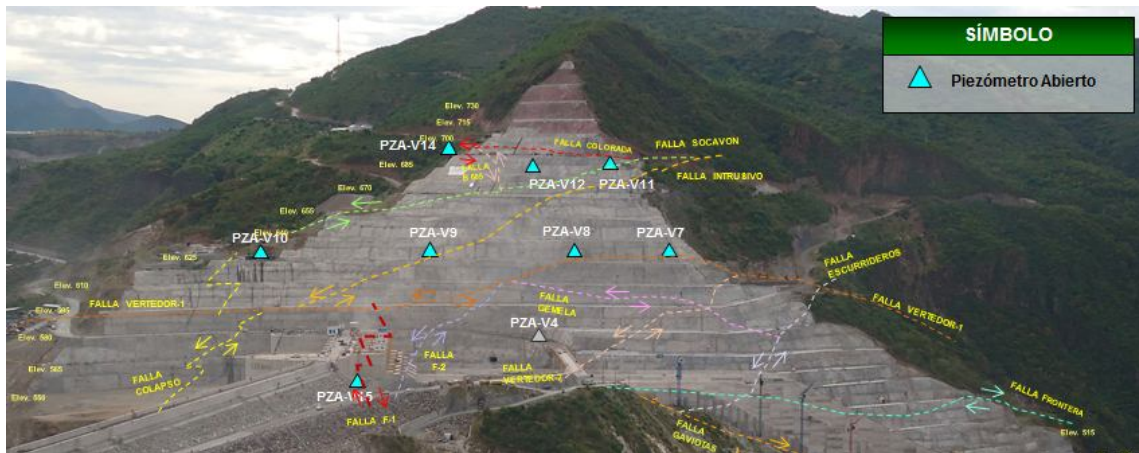
Figura 5.14. Ubicación de piezómetros abiertos instalados en la obra de excedencias (GEIC, Octubre 2012).
