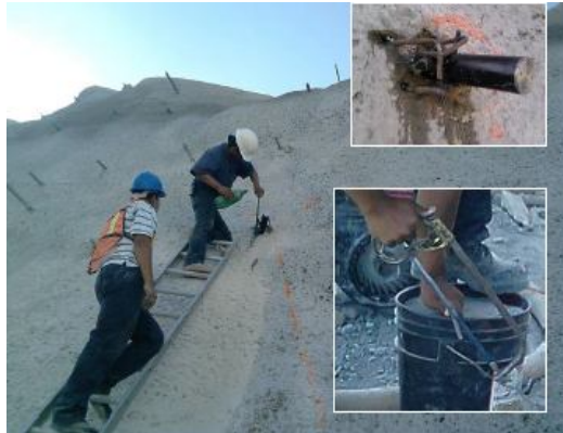
Fotografía 4.3. Colocación de cabezal y anclas de sujeción. Arriba cabezal terminado, abajo taquetes de acero (EMG-GEIC, Mayo 2010).
