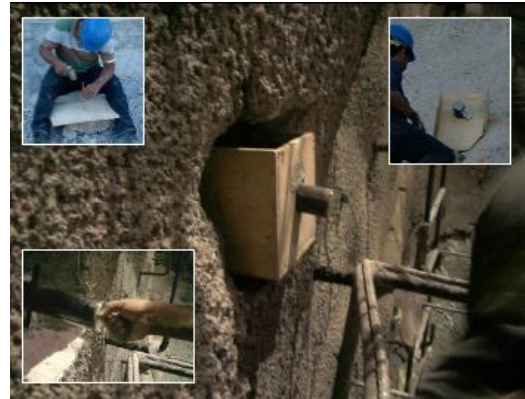
Fotografía 4.4. Colocación de cimbra, arriba izquierda corte de cimbra en sitio, abajo izquierda medición de distancias regulares, derecha cimbra diagonal (EMG-GEIC, Mayo 2010).
