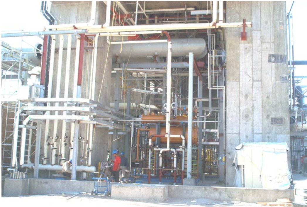
Fig. 3.12 Detalle de columnas de cimentación de turbina de vapor. Nótese la escala humana de referencia
