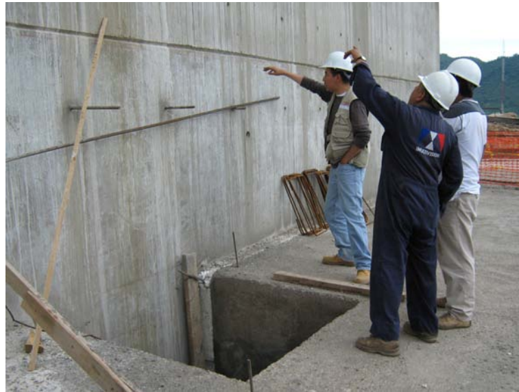
Figura 4.9. Actividades previas a la instalación de sensores
