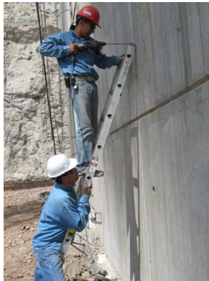
(b) Perforación de agujeros en el pilón 5
