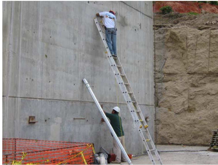
(a) Verificación preliminar a la instalación del sensor
