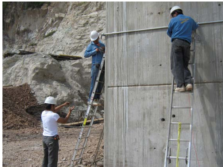
(a) Colocación de protección de cables y conectores contra daño mecánico
