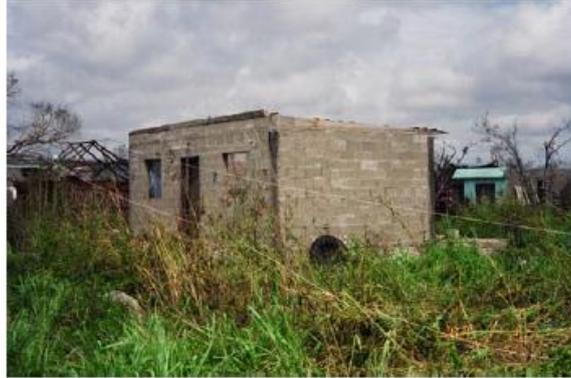
Figura 6.1. Daño en vivienda de mampostería confinada con material precario en techo.
