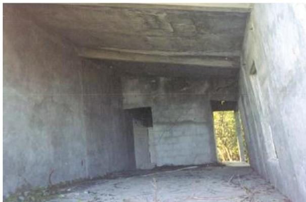
*Figura 5.3. Falla por flexión del muro debido al giro de la cimentación en una estructura de mampostería confinada (H. Toledo; Huracán Pauline, Oaxaca, México, 1999).*
