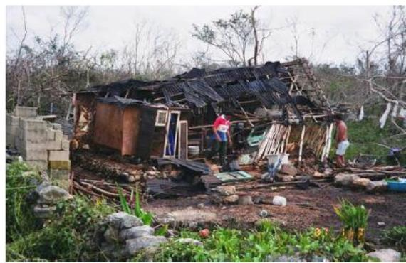
Figura 6.3. Falla de vivienda con material precario en techos y mampostería confinada en los muros, (H. Toledo, 1999).
