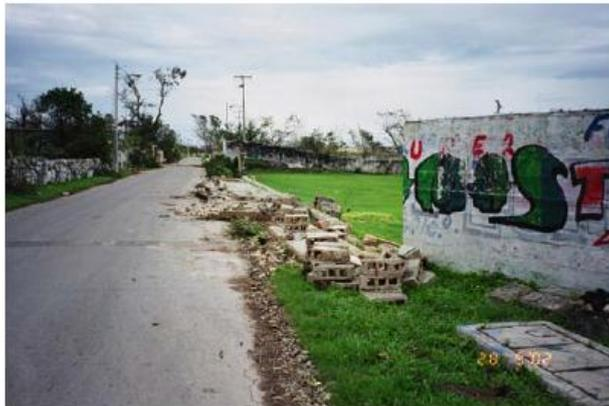
*Figura 5.2. Daños y falla en muros de mampostería usados en bardas de colindancia, (H. Toledo; Huracán Pauline, Oaxaca, México, 1999).*
