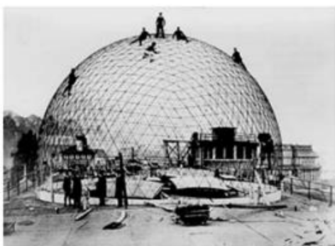
Figura 1.10.1 Planetario Zeiss en Jena Alemania. Forjado de acero. (Fuente: ver referencia [8])
