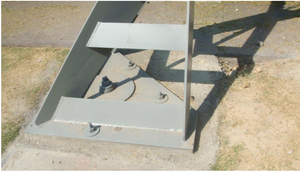
Figura A.2 Apoyo metálico sobre placa base
