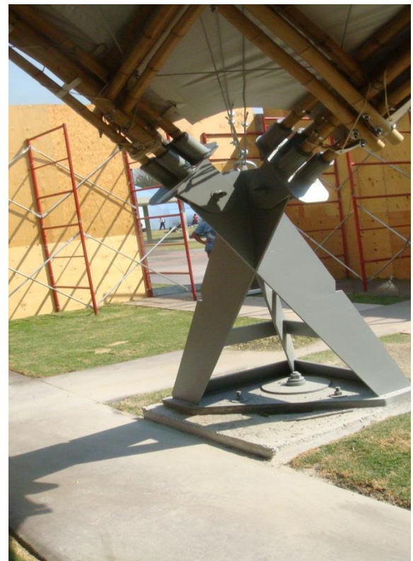
Figura A.3.2 Apoyo metálico. Perspectiva
