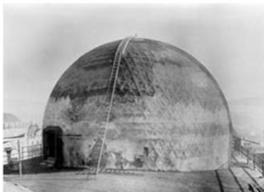
Figura 1.10.2 Planetario Zeiss en Jena Alemania. Domo después de aplicar el concreto lanzado. (Fuente: ver referencia [8])
