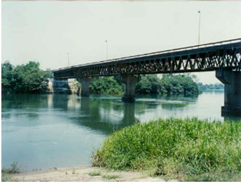
Fig. 3.9 Vista lateral del “Puente Caracol”
