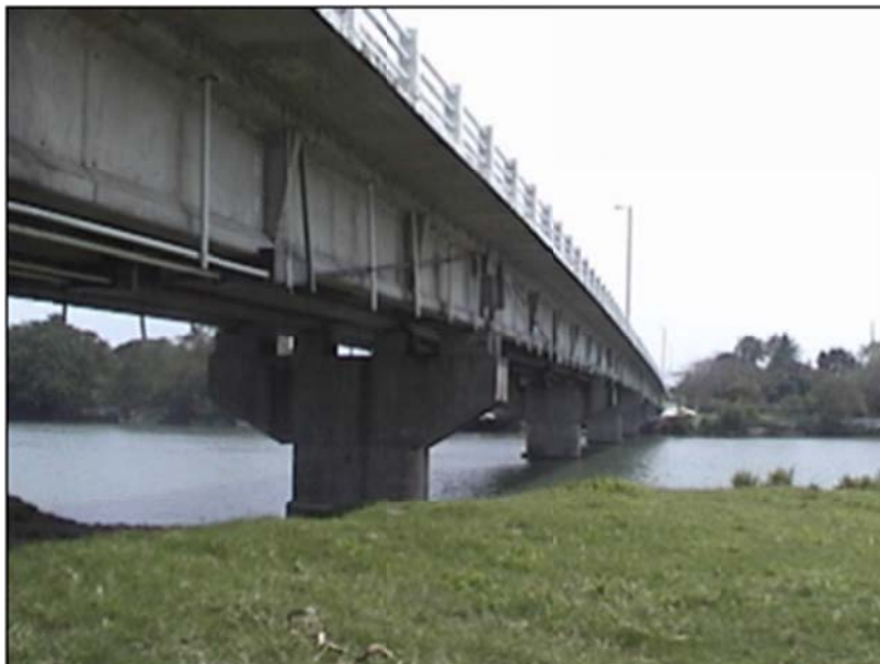
Fig. 3.16 Refuerzo del “Puente Nautla”
