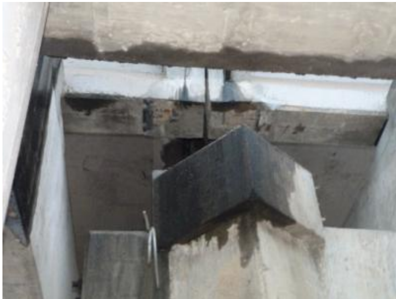
Fig. 3.34 Detalle de antiguo punto de apoyo. Se recorrió con respecto a los apoyos nuevos
