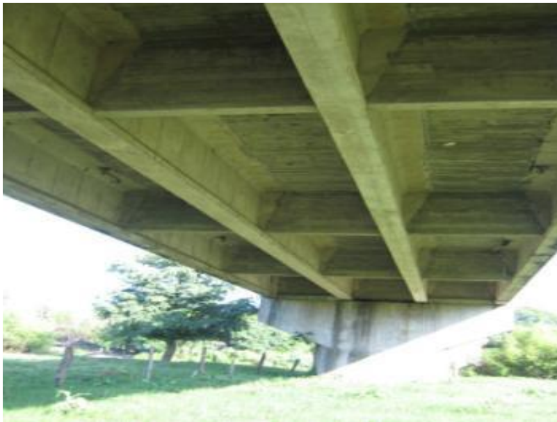
Fig. 3.22 Vista inferior de la cubierta del Puente "Raudal"
