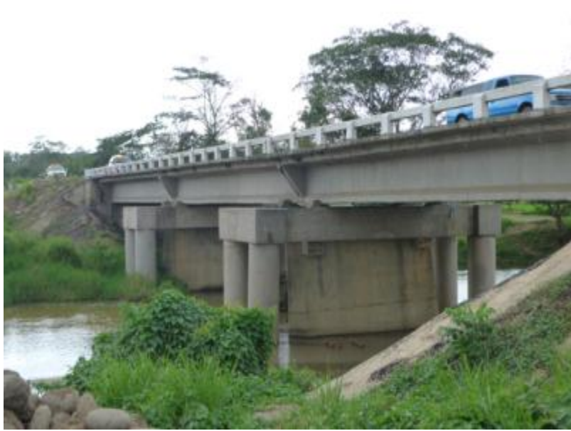
Fig. 3.31 Vista panorámica del puente "Jimba"
