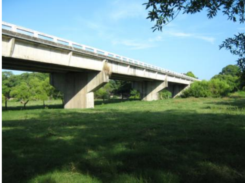
Fig. 3.21 Panorámica del puente "Raudal"
