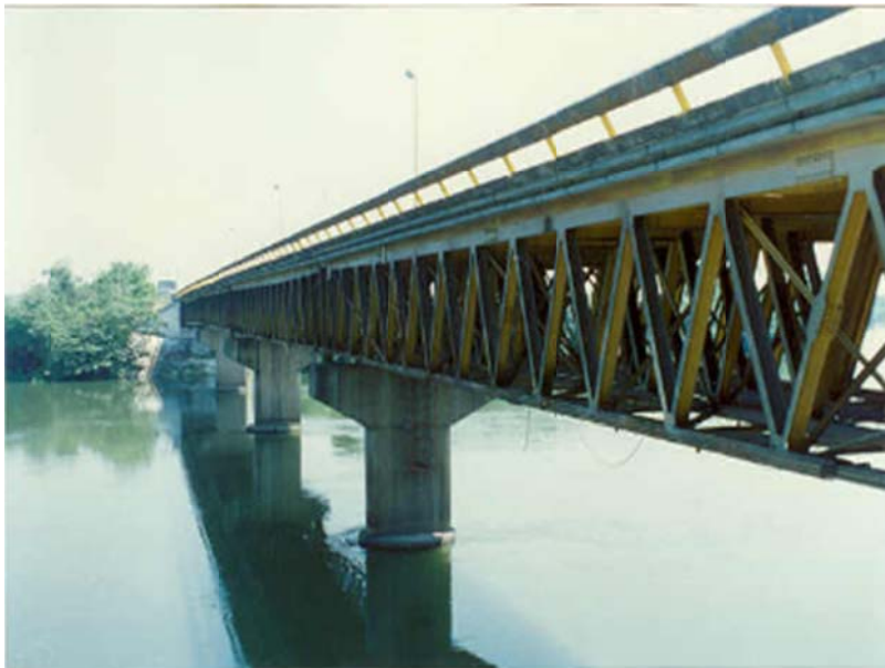
Fig. 3.10 Estructura del “Puente Caracol”
