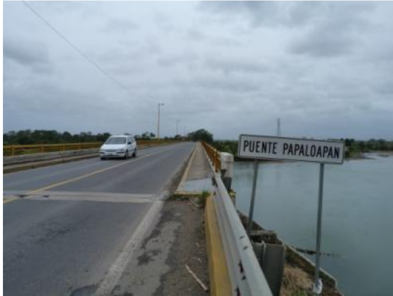
Fig. 3.6 Vista de puente “Papaloapan” con cargas vehiculares
