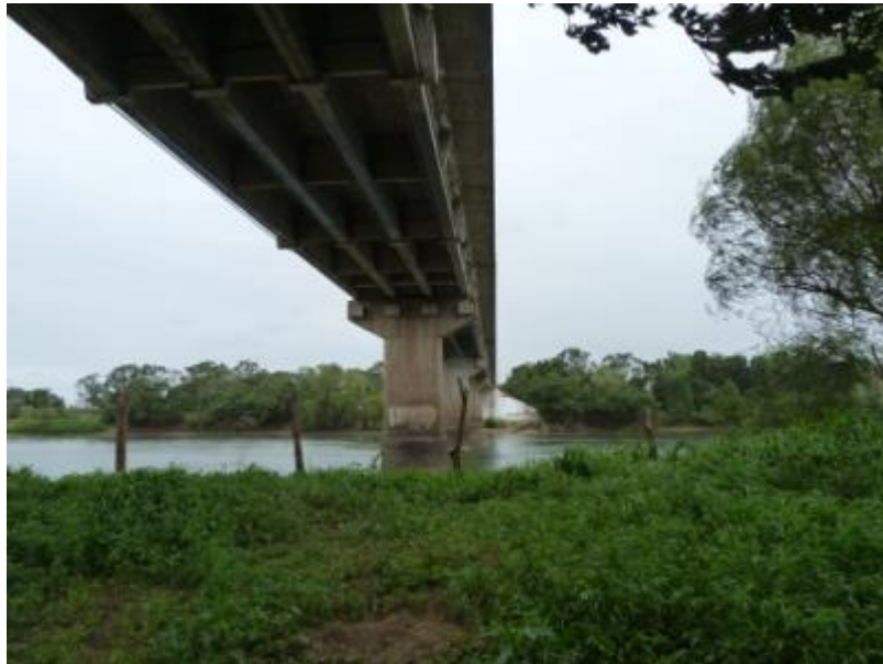
Fig. 3.5 Vista panorámica del puente "Papaloapan"
