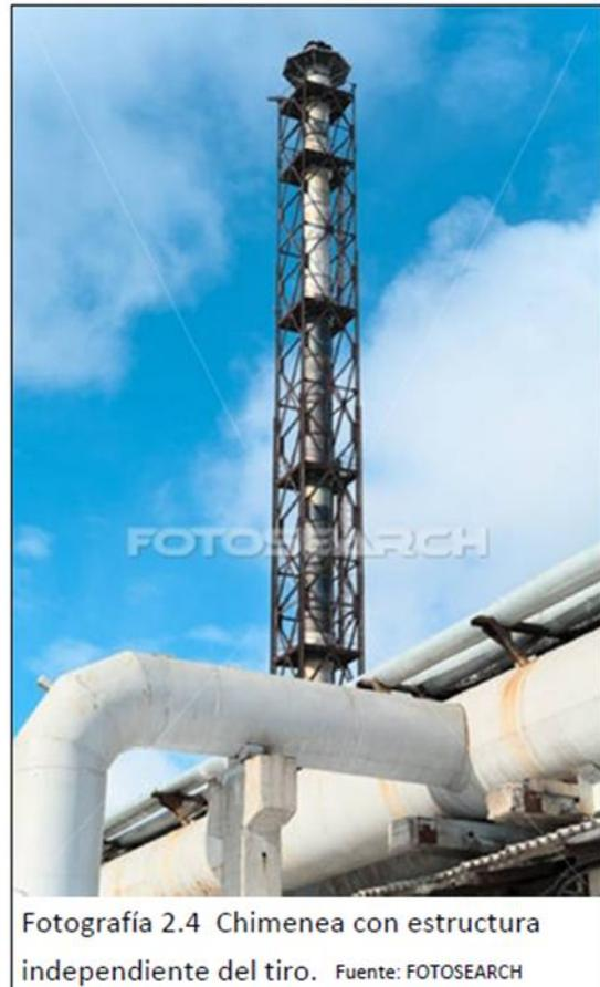
Fotografía 2.4 Chimenea con estructura independiente del tiro. Fuente: FOTOSEARCH
