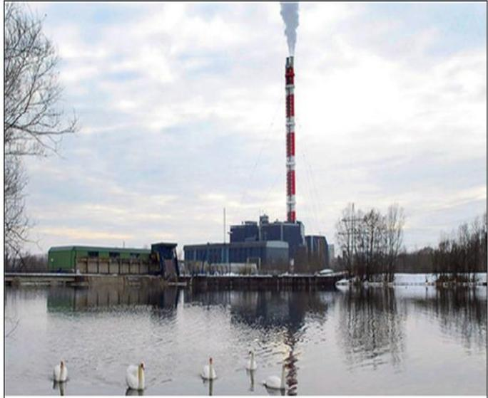
Fotografía 2.2 Chimenea atirantada de 176 m de alto en Neudorf Austria.
