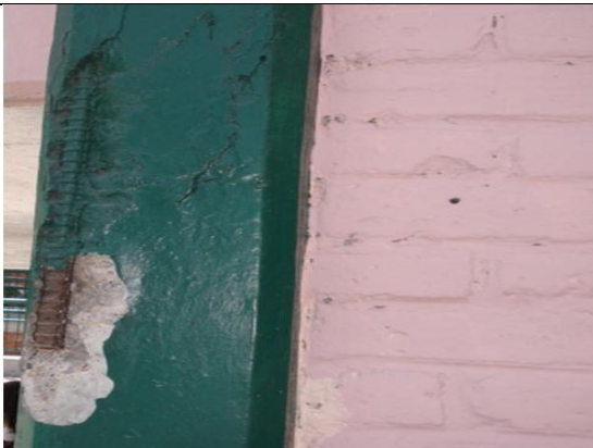
Ilustración 3 Exposición del acero estructural
