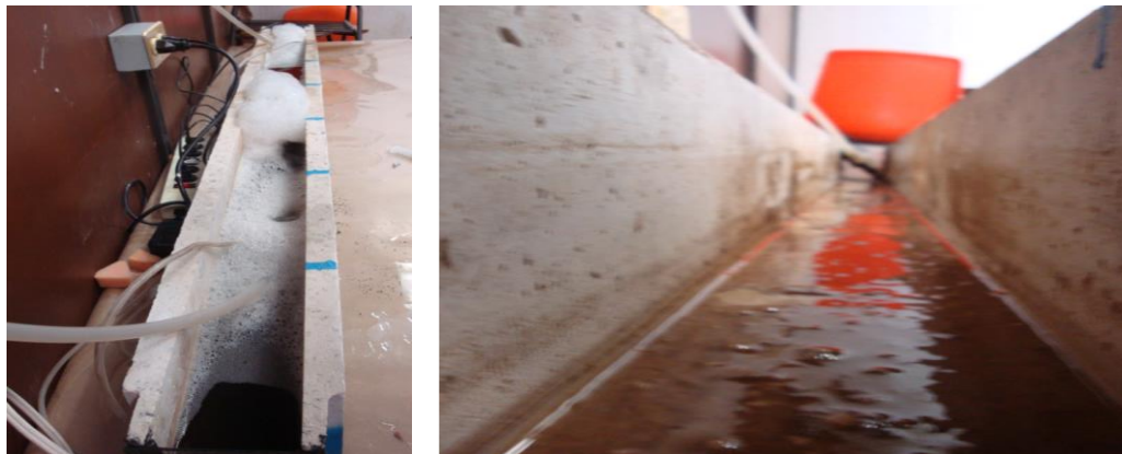
Fig. 8.10 A la derecha se muestra la operación del canal con aguas negras y a la izquierda los sedimentos que se adhieren a las paredes una vez desalojada el agua.
