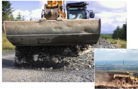
Figura 1.9. Geomalla multiaxiales con piedra site-won, Scotland.
