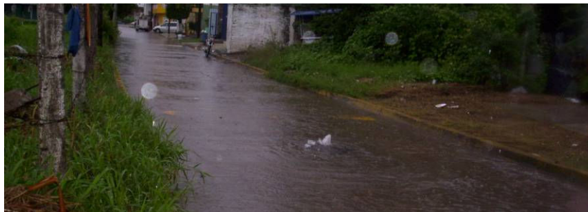
Figura 3.9. Alcantarilla de drenaje sanitario rebosando agua hacia la calle.
