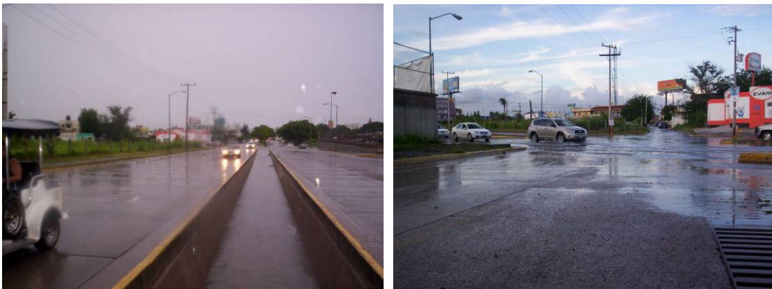
Figuras 3.7 y 3.8. Canal azolvado sobre el que no circula libremente el agua. Colector de agua sobresaturado de agua, que libera agua proveniente de otro sector.
