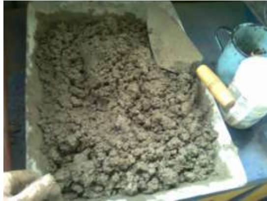
Figura 43. Preparación de la mezcla
