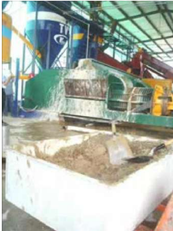
Figura 18. Preparación de la mezcla.
