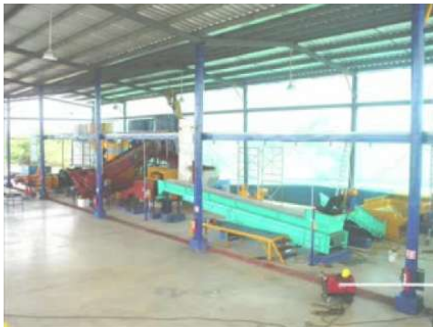
Figura 19. Vista de la planta
