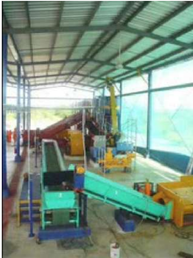
Figura 16. Vista de la planta de fabricación
