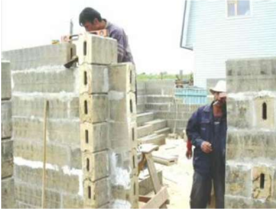
Figura 24 .Aplicación en construcción
