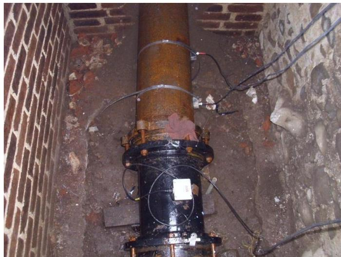
Figura 3.19. Medidor instalado en la presa de Socoyolapan.
