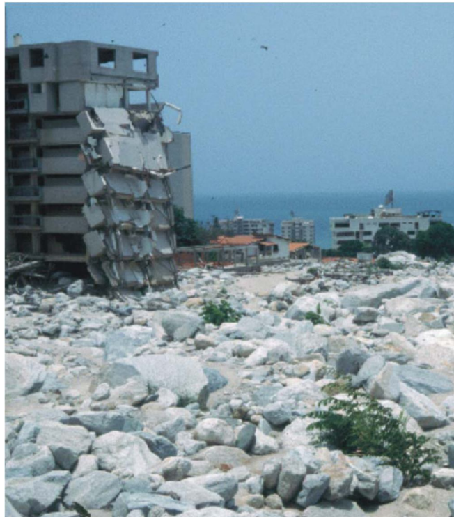
Figura V.2.- Daños a edificios por impacto de bloques en pilares (Cortesía Zhang & Sucheng, 2000).
