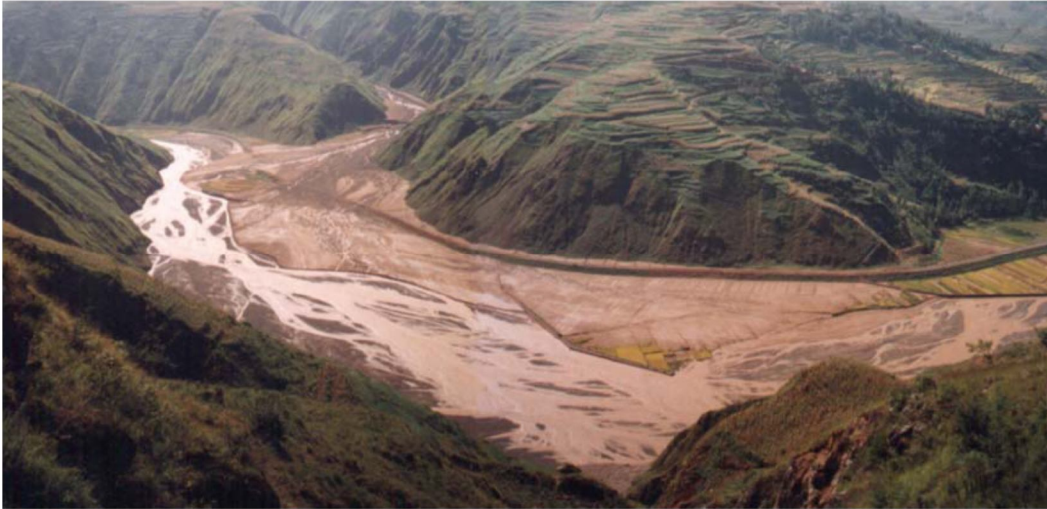
Figura V.1.- Corte de línea ferroviaria debido a un flujo de derrubios en la provincia de Yunnan, China (Cortesía Zhang & Sucheng, 2000).
