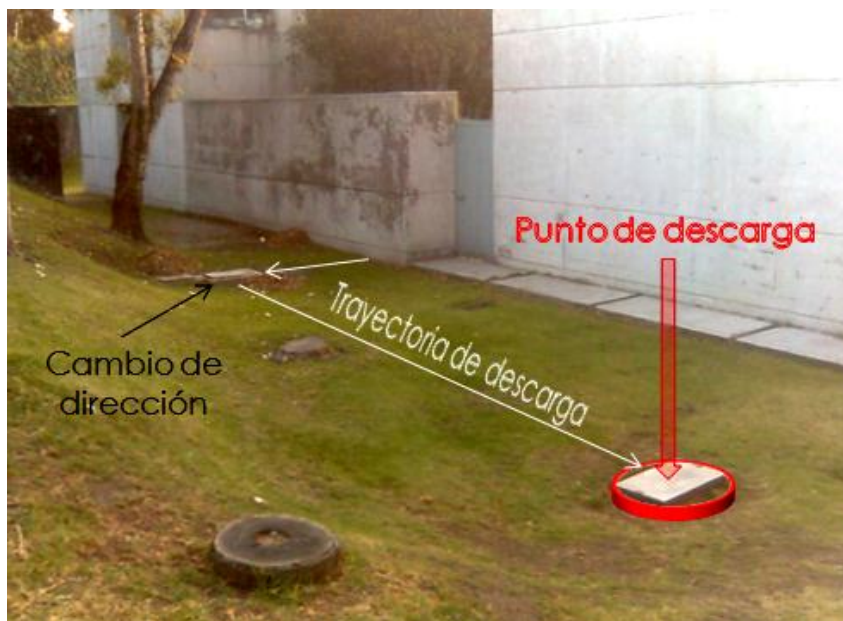
Figura A1-2. Punto de descarga de aguas residuales de la DICyG
