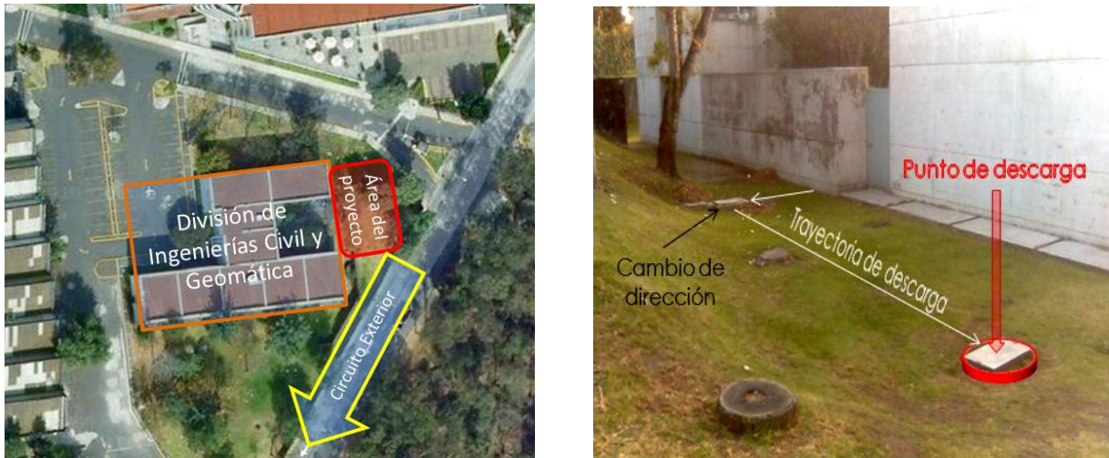
Figura II-1. Izq. Ubicación del edificio y área de proyecto; Der. Punto de descarga original del edificio. Fuente: Imágenes ©2012 GeoEye. Datos del mapa ©2012 Google, INEGI
