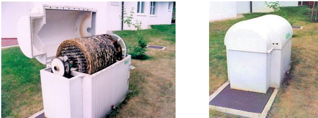
Figura III-24. Sistema de tratamiento compacto HERVA modelo UH-1.5 (cortesía de SANDE Y DIAZ, SL)
