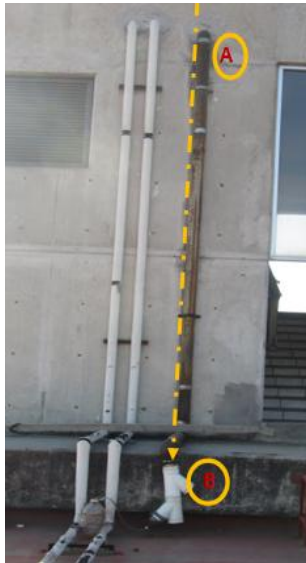
Figura 27 Adaptación realizada para la toma de muestras de agua de lluvia.
