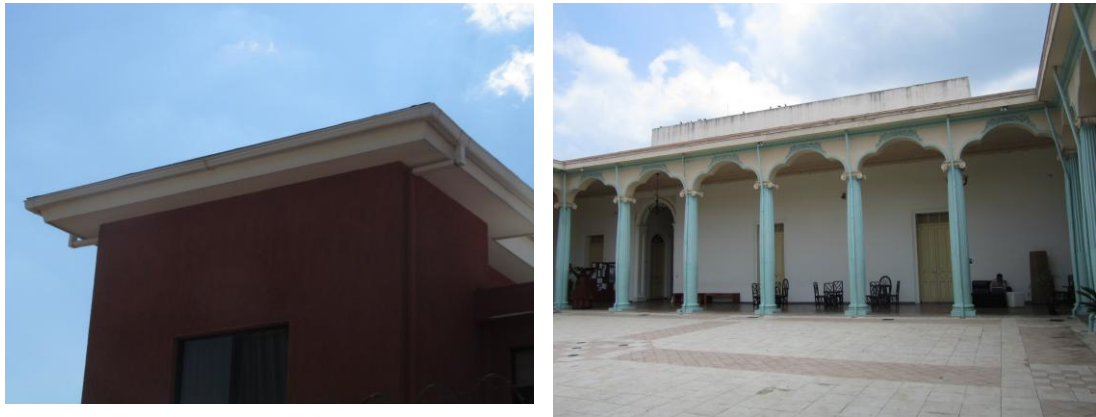
Figura 13 Canaletas utilizadas en la captación del agua de lluvia sin alterar el diseño arquitectónico de la estructura (Centro cultural Santa Tecla, El salvador)
