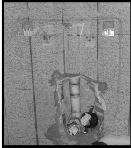
Figura 22 Desinstalación de Mingitorios
