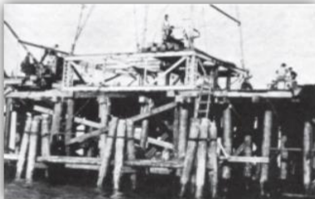
Figura 2. Vista cercana de una plataforma de madera, una milla costa afuera de la playa de McFaddin, Texas, en 1938. (Fuente: Conceptos básicos de Ingeniería Civil Costa Afuera, Tomo I.)
