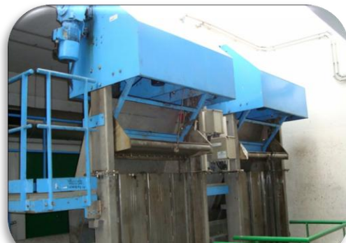
Ilustración 5. Rejilla de limpieza mecánica.
