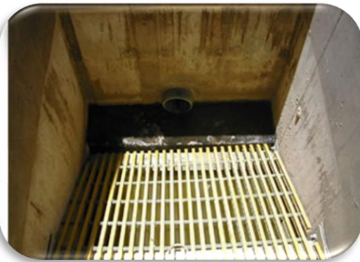
Ilustración 4. Rejilla de limpieza manual.
