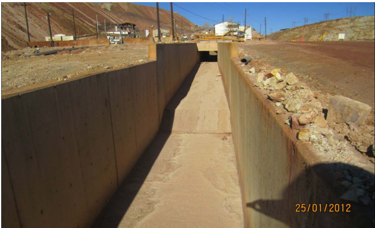
Imagen 10: Reductor de pendiente en canal de concreto, Cadenamiento 00+ 400.
