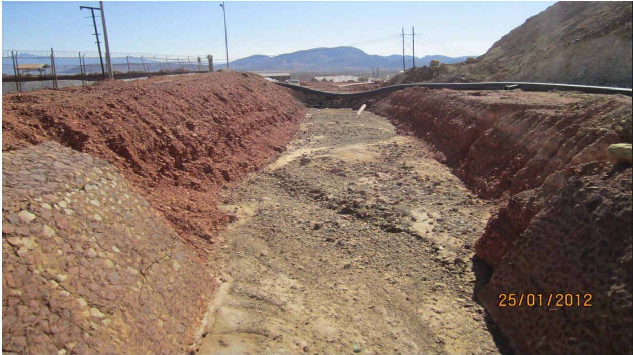
Imagen 15: Termina canal zampeado de sección trapecial 6.00 X (h variable), Cadenamiento 01+ 007.
