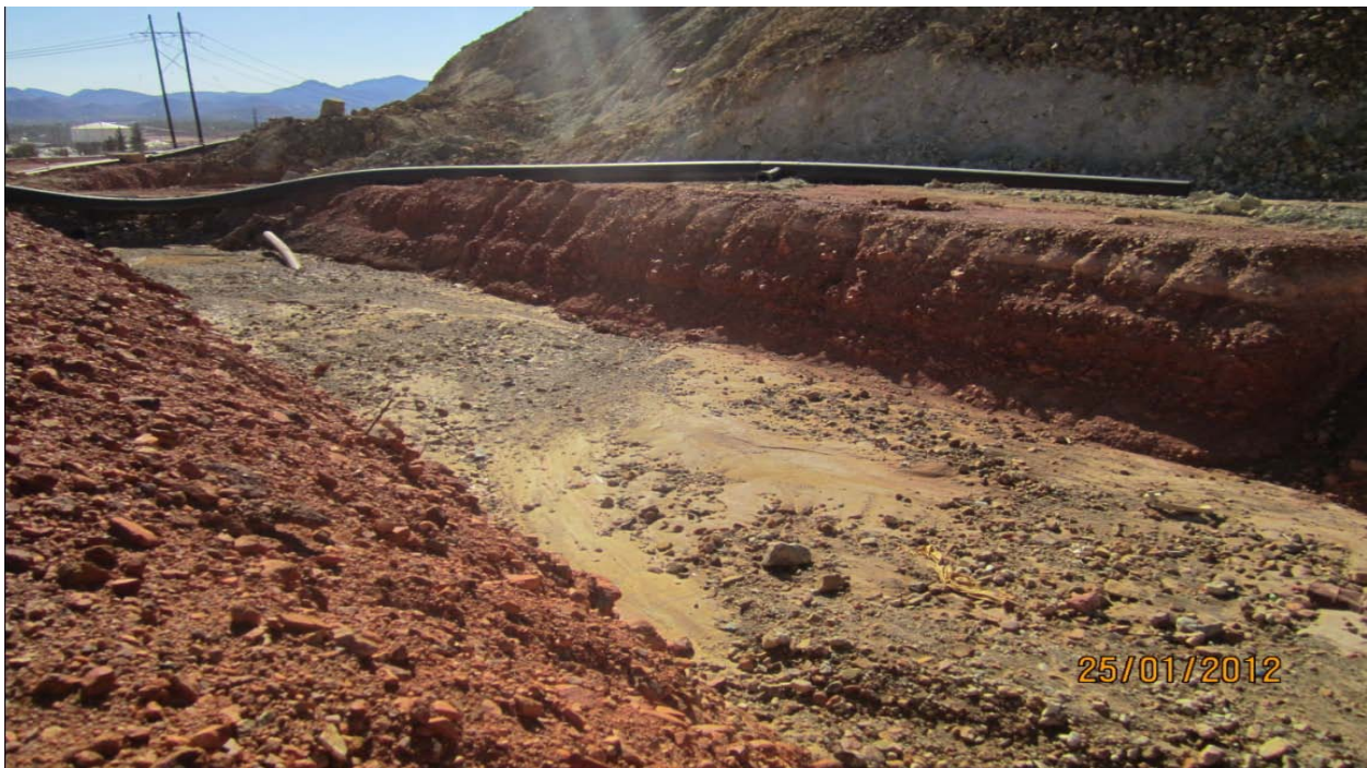
Imagen 15: Canal excavado de sección trapecial 6.00 X (h variable), Cadenamiento 01+ 030.
