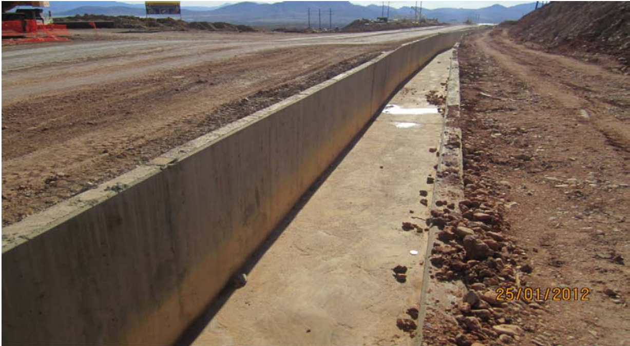
Imagen 3: Canal de concreto sección rectangular 2.00 X 1.80 (m), Cadenamiento 00+ 090.
