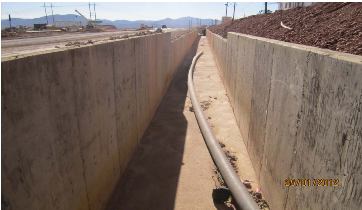
Imagen 6: Canal de concreto sección 2.00 X (h variable) (m), Cadenamiento 00+ 280.
