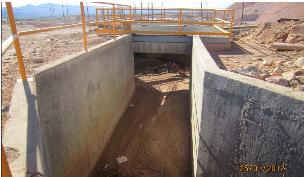
Imagen 8: Caja vertedora, sección 420 X 3.09 (m), Cadenamiento 00+ 355.
