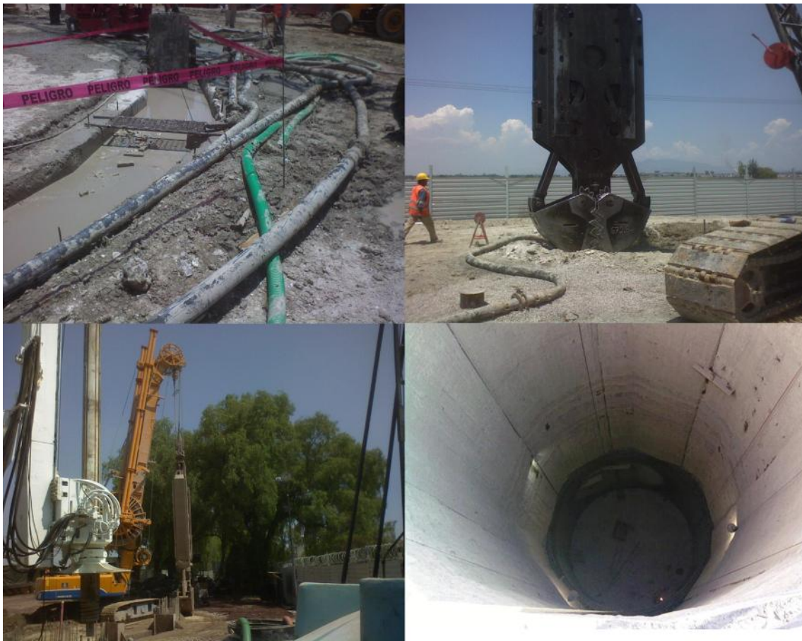
Figura 3. Lumbrera con muro Milán
