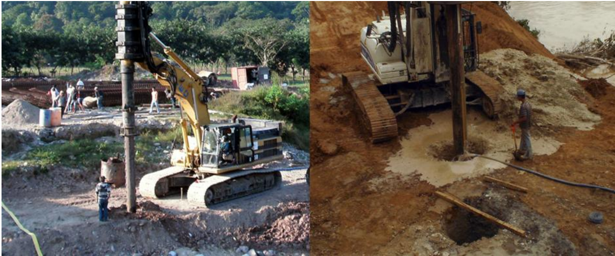
Figura 4. Lumbrera con pilas secantes
