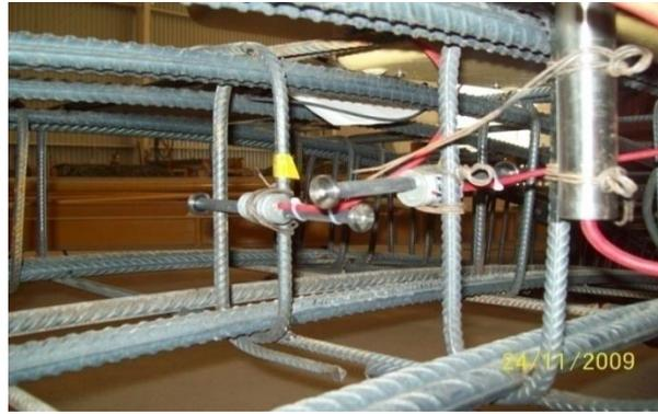
**Foto 8a.** Colocación de deformímetros para monitoreo del concreto en dovela de revestimiento primario en TEO.
