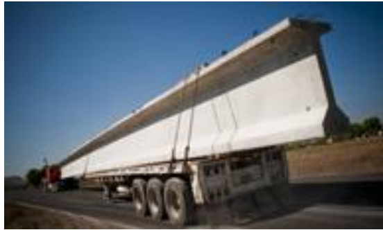
Transporte de trabe prefabricada tipo AASHTO.
