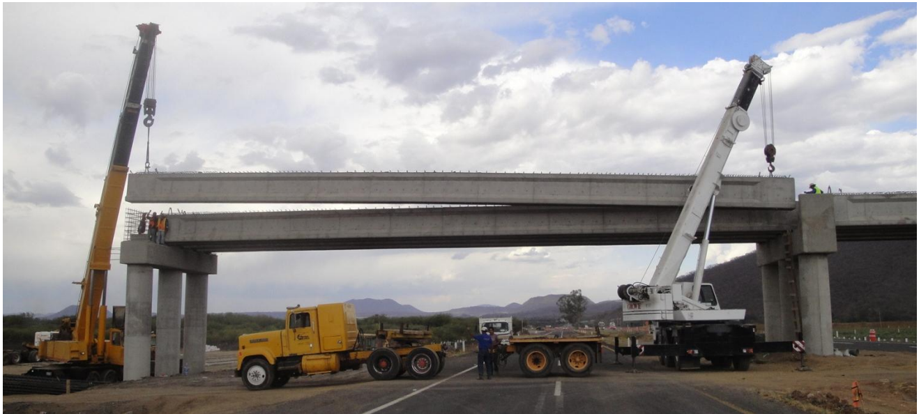
Izaje de trabe prefabricada tipo AASHTO para puente.
