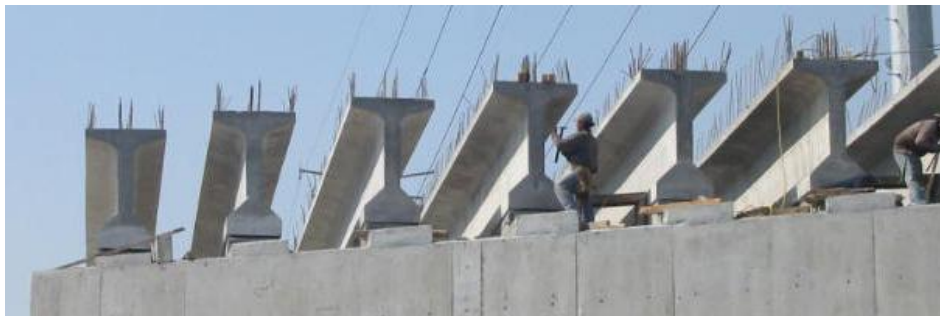
Colocación de trabe prefabricada tipo AASHTO para puente.
