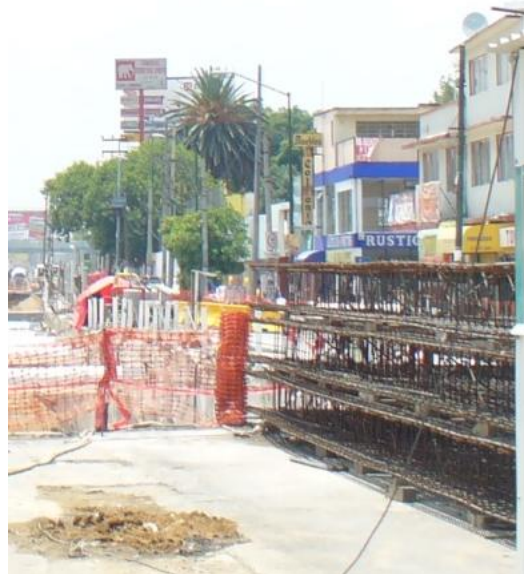
Vista de las parrillas de acero de refuerzo de Muro Milán: imagen I-XIV
