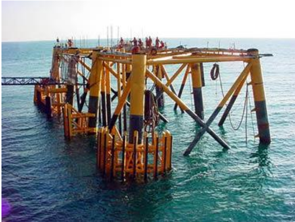
Fig. 2.1.5- Estructura tipo Jacket en alta mar.
