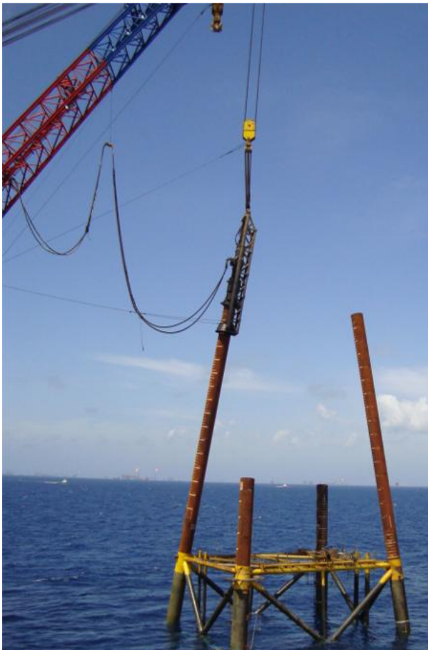
Fig. 2.1.8 Hincado de pilotes en plataforma tetrápoda.
