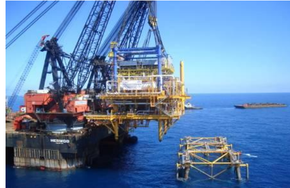
Fig. 2.2.21.- Acercamiento del barco grúa a la subestructura.
