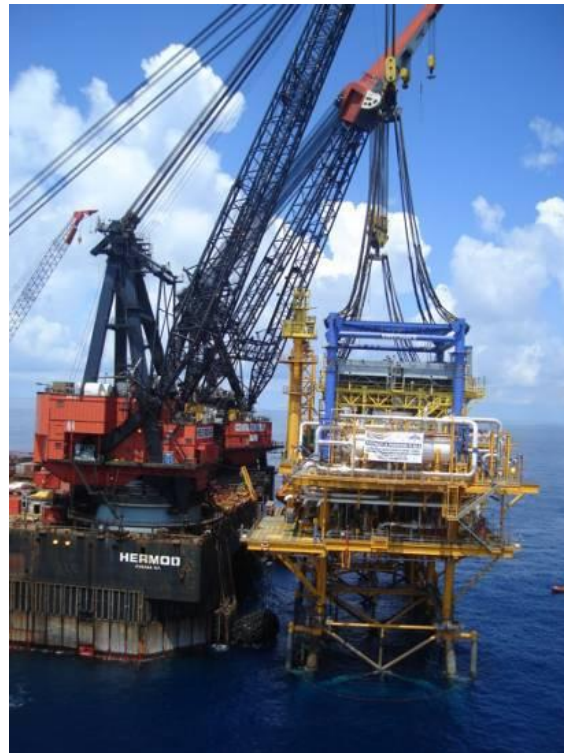
Fig. 2.2.22.- Instalación de la superestructura.
