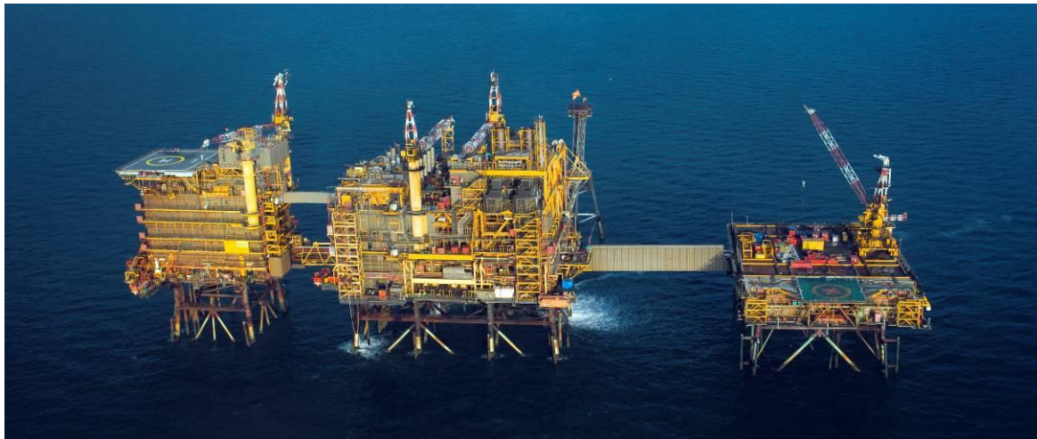
Fig. 1.2.1- Conjunto de plataformas típicas de acero.
