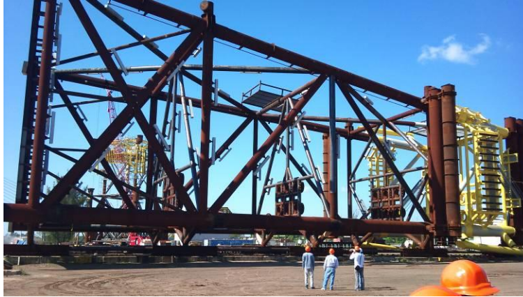
Fig. 2.2.7.- Jacket en proceso de fabricación.
