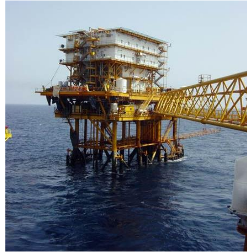
Fig. 2.1.3- Superestructura de una plataforma habitacional.
