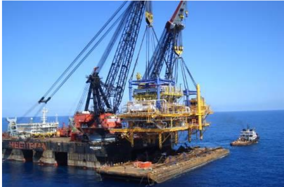
Fig. 2.2.20.- Cubierta siendo levantada por grúa.
