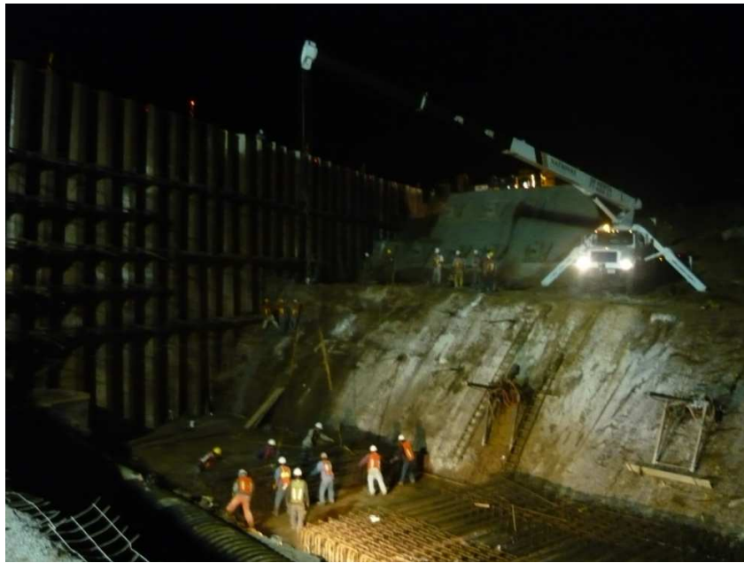
FOTO 3.5 COLOCACIÓN DE MÓDULOS DE ACERO DE REFUERZO DE LA CIMENTACIÓN.
