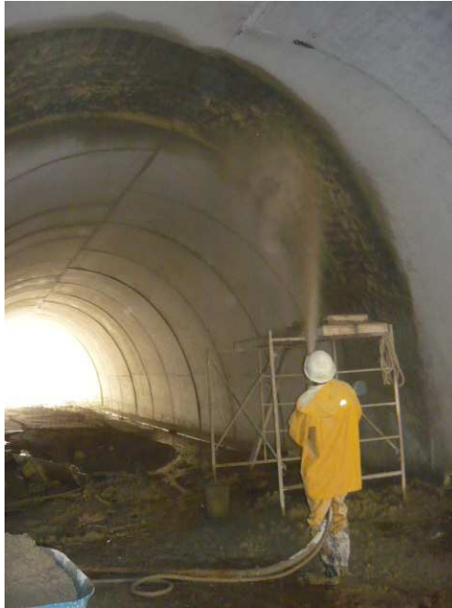
FOTO 3.9 VISTA DEL COLADO DE DALA DE ACOPLAMIENTO CON CONCRETO LANZADO.
