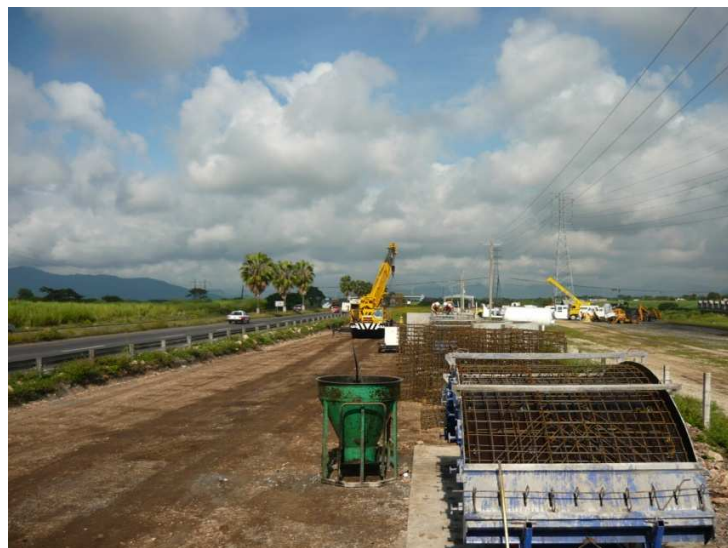
FOTO 4.1 VISTA GENERAL DEL PATIO DE PREFABRICADOS.
