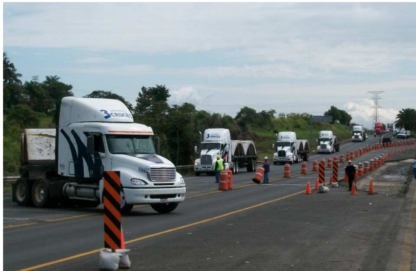
FOTO 4.5 TRANSPORTE DE DOVELAS.
