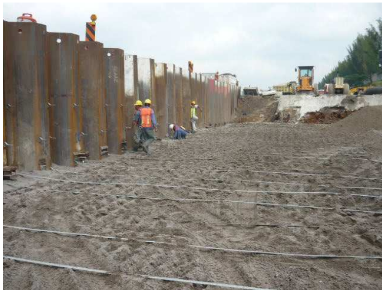
FOTO 3.7 ESQUEMA DEL PROCEDIMIENTO DE RELLENO DE BÓVEDA.
