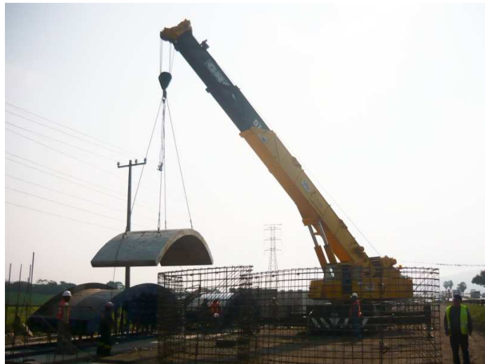
FOTO 4.4 MANIOBRA DE DESMOLDE.
