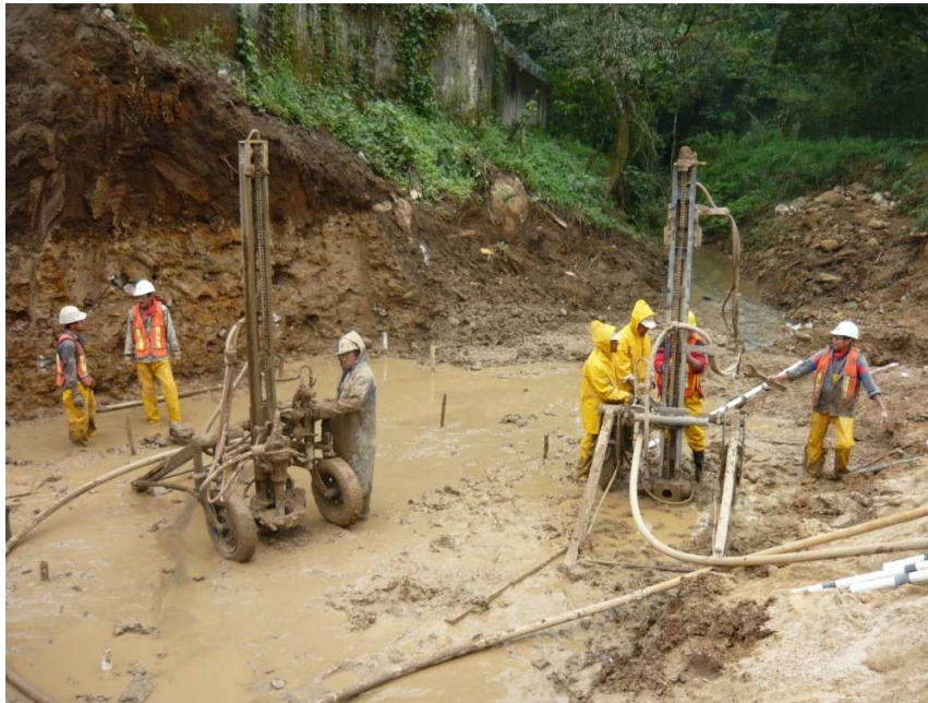
FOTO 3.4 TRABAJOS DE PERFORACIÓN PARA INCLUSIÓN DE LECHADA.
