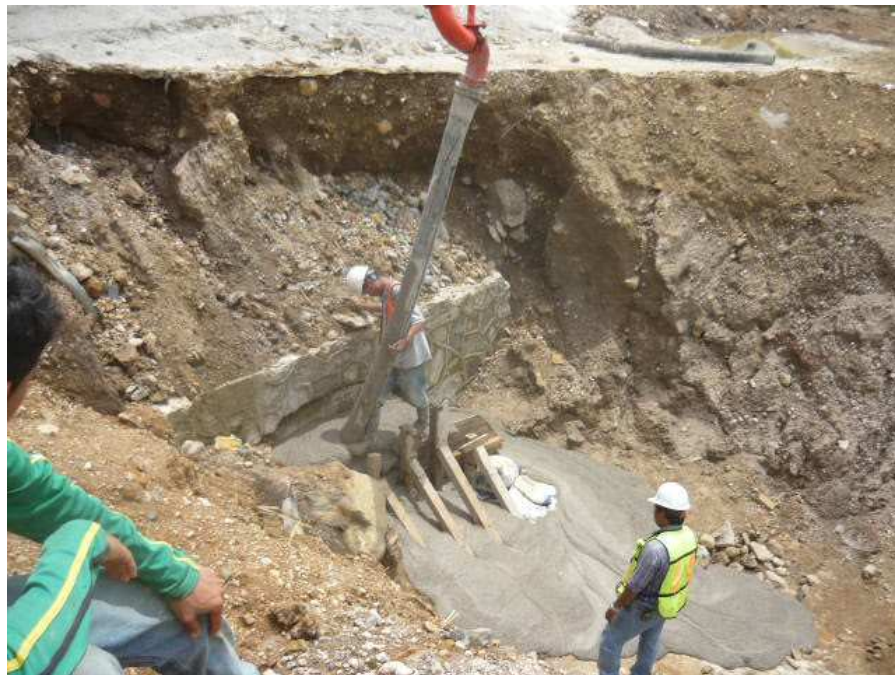
FOTO 3.10 FINALIZACIÓN DEL PROCEDIMIENTO DE CANCELACIÓN DE ALCANTARILLA EXISTENTE.
