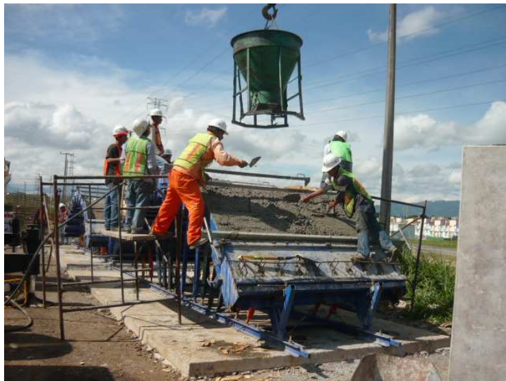
FOTO 4.2 PROCEDIMIENTO DE COLADO DE DOVELAS.
