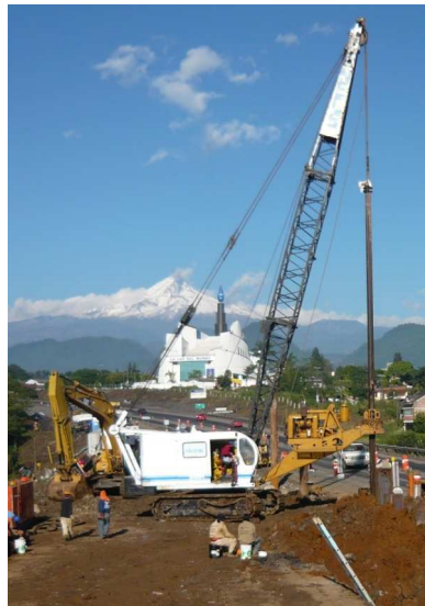
FOTO 3.1 PRIMER PLANO DE GRÚA EQUIPADA CON PERFORADORA.
