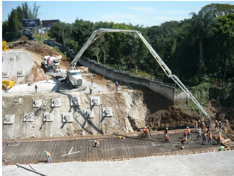
FOTO 3.6 COLADO DE CIMENTACIÓN AGUAS ABAJO.
