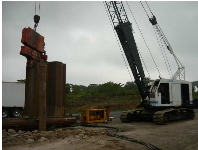
FOTO 3.2 VISTA DEL HINCADO DE LA TABLA ESTACA CON AYUDA DE MARTILLO VIBRATORIO.
