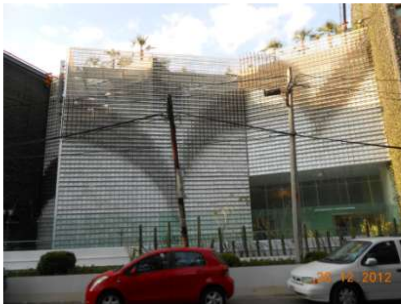
Figura I.3. Vista Fachada Principal
