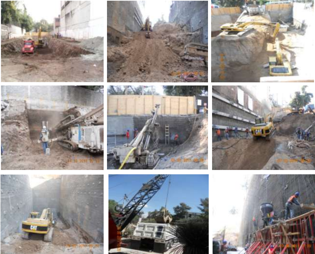
Figura IV.1. Procedimiento de Excavación
