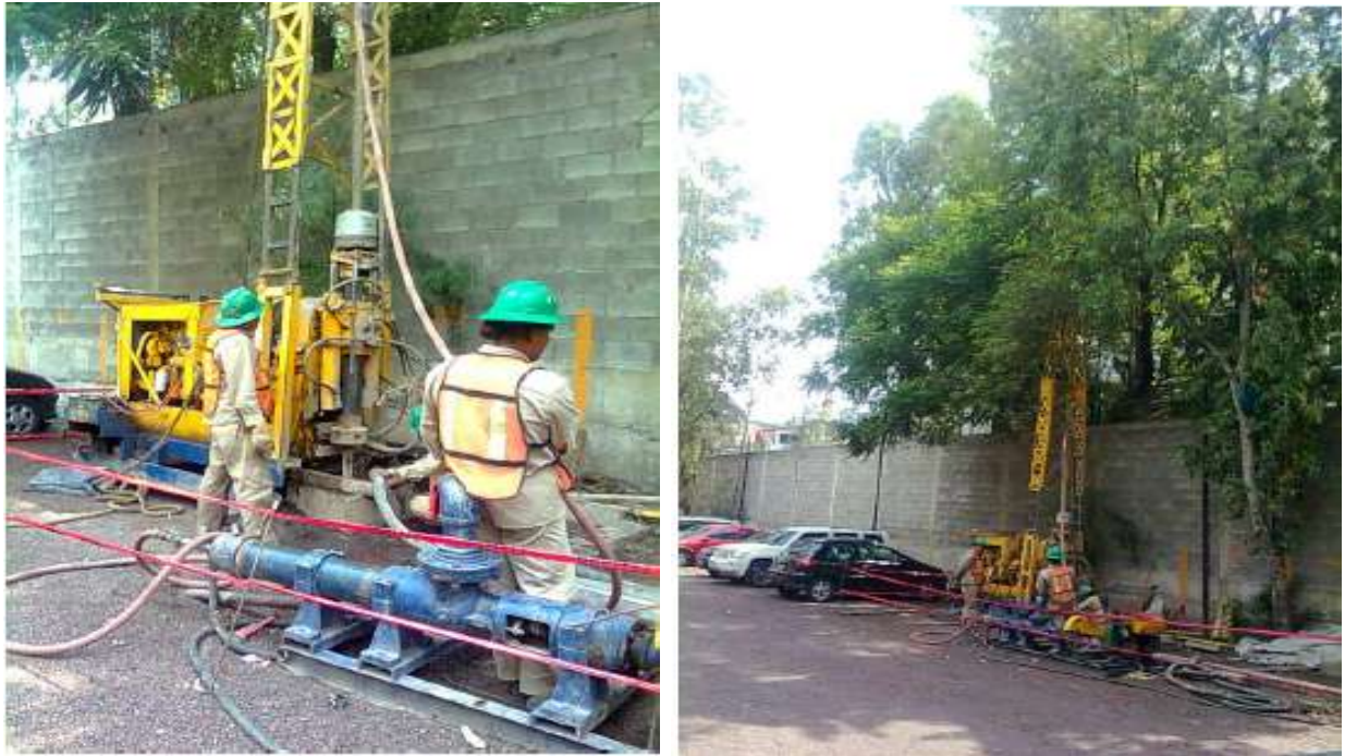
Figuras III. 5 Sondeo Penetración Estándar SPE-1
