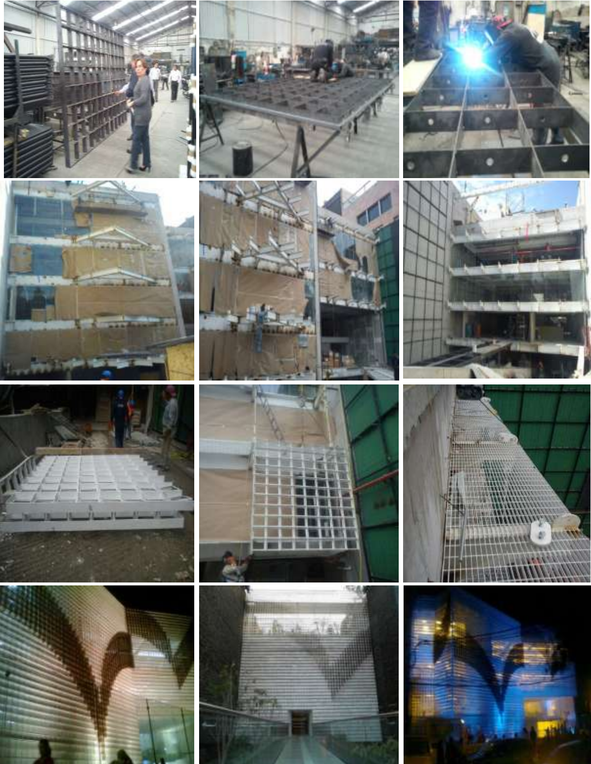
Figura II. 24 Procedimiento constructivo de la Fachada Artística
