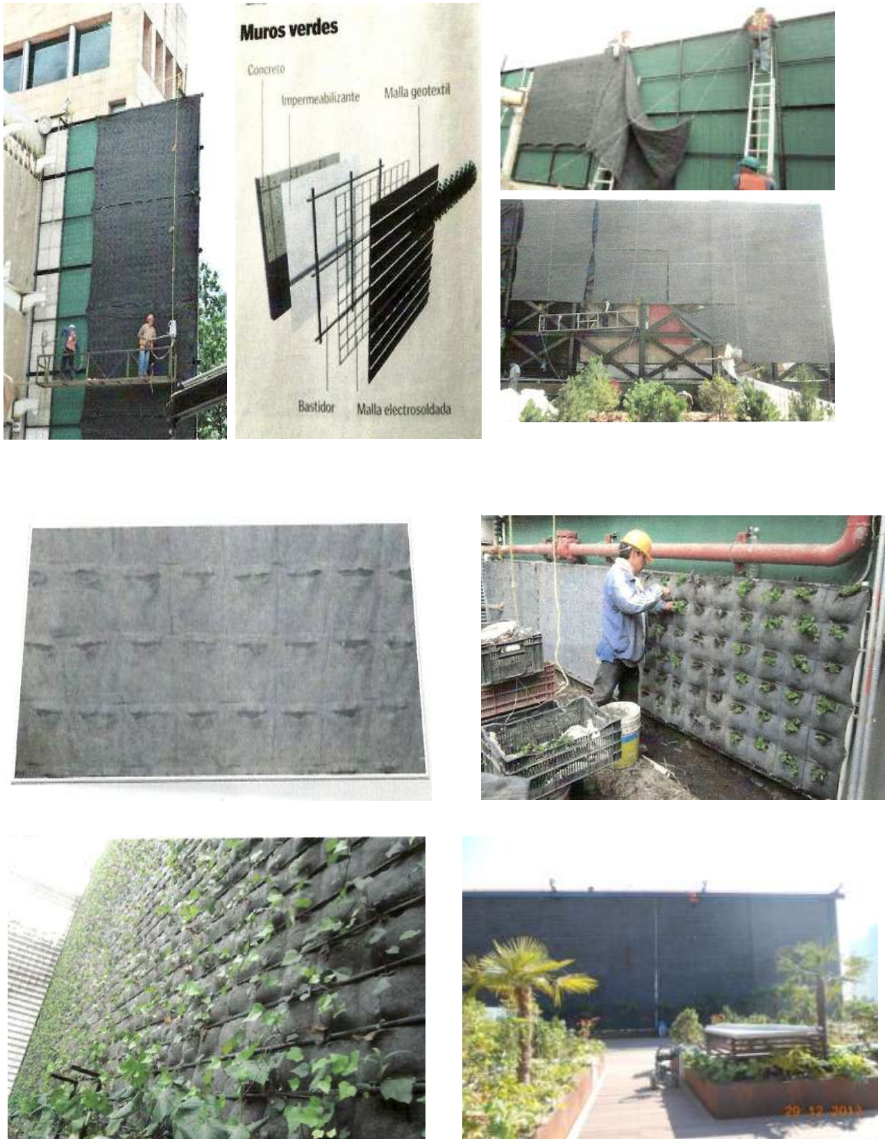
Figura II.18 Procedimiento constructivo en Muros Verdes
