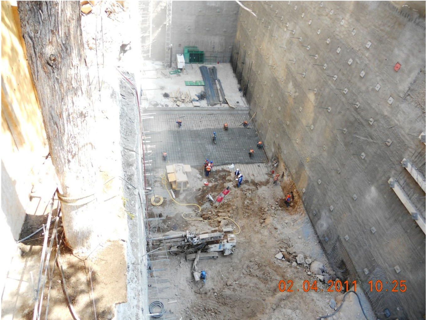
Losa de Cimentación - 2 de Abril de 2011
