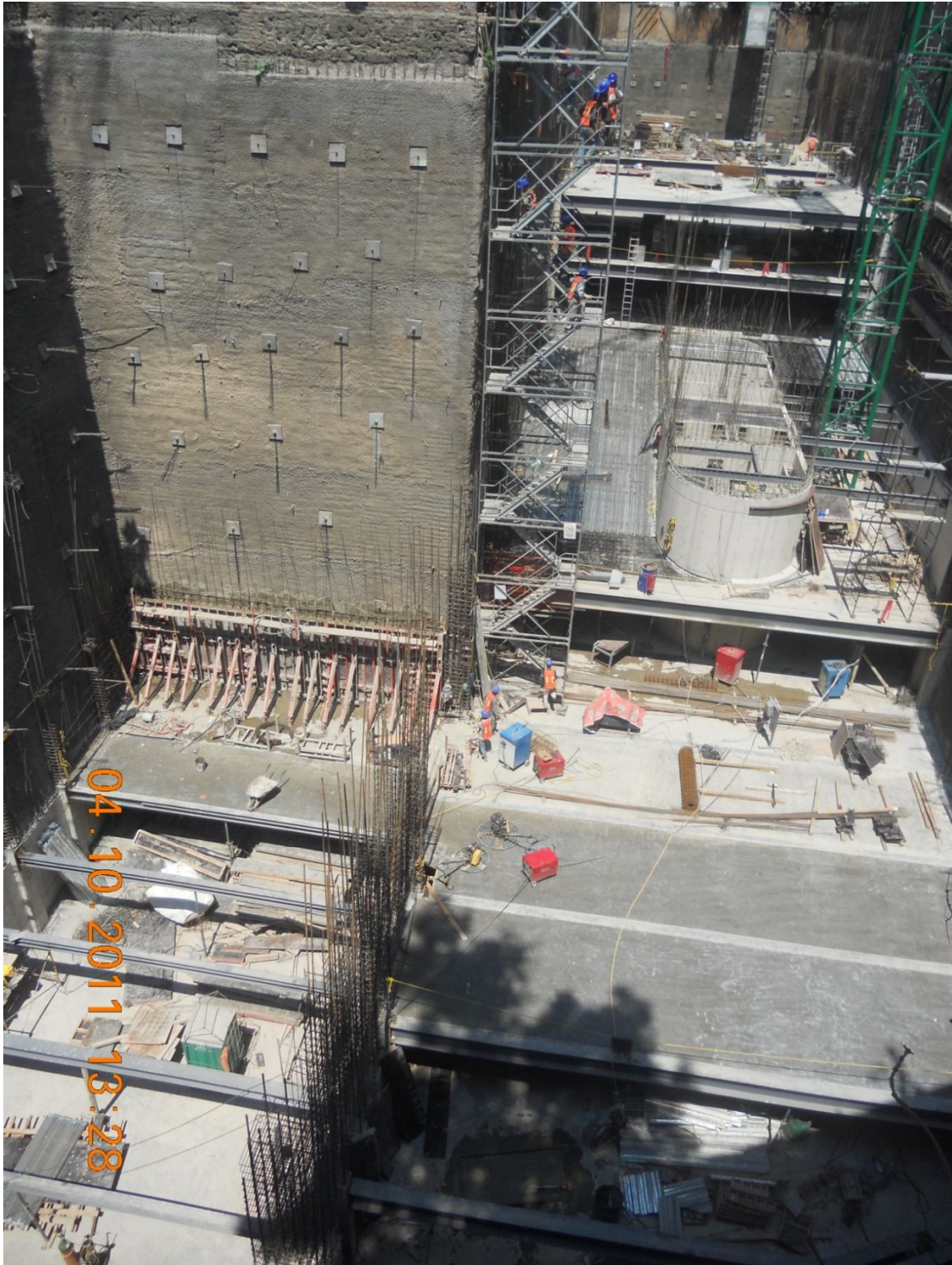
Estructura metálica y de concreto – 4 de Octubre de 2011
