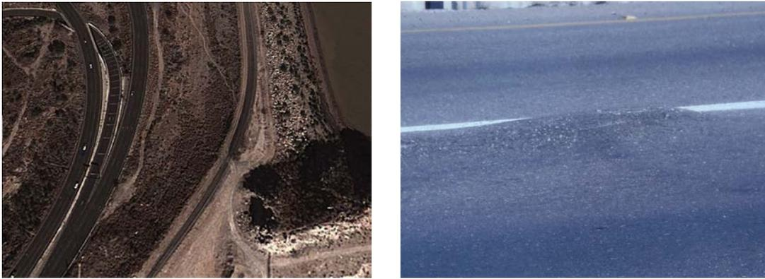
**DAÑO EN PAVIMENTO FLEXIBLE POR VIRAJE A VELOCIDAD DE OPERACIÓN DE VEHÍCULO PESADO.**
