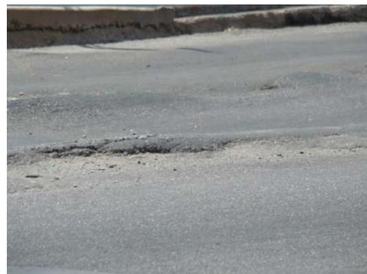
**DAÑO EN PAVIMENTO FLEXIBLE POR FRENADO DE VEHÍCULOS PESADOS EN PARADA DE AUTOBÚS.**
