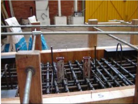
(a) Detalle de ductos de postensado
