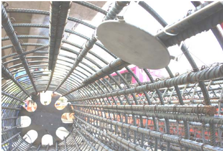
Figura 2.10 Vista de celda de presión en armado de pila (Mendoza et al. , 2012)
