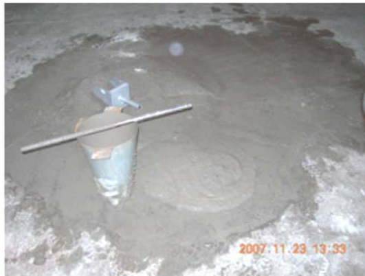
Prueba de revenimiento
