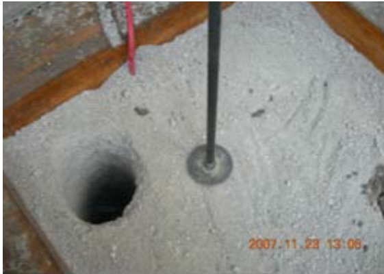
a) Barra de acero de ½ pulgada de espesor con disco en su punta, previo a su introducción en el barreno
