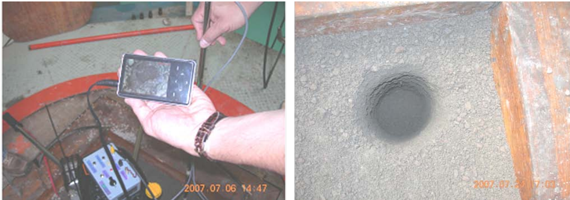
Figura 3.8 Inspección visual con boroscopio del interior de las perforaciones
