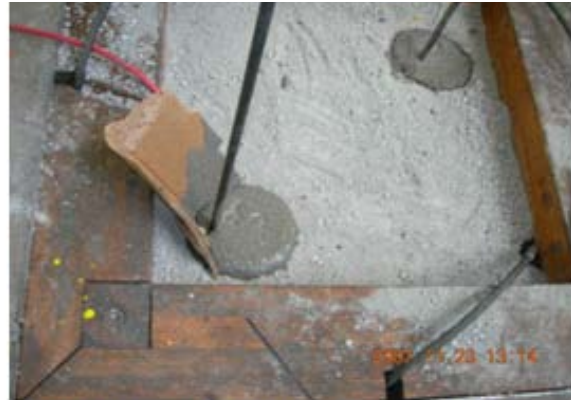
b) Vista de los modelos de pila ya colados
