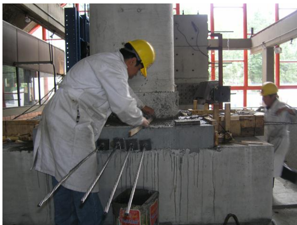
Figura 3.16. Enrasado de la losa postensada en la conexión cimentación-columna
