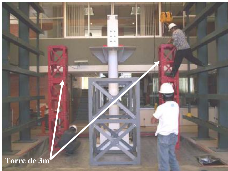
Figura 3.23. Transporte de piezas sobre la mesa vibradora
