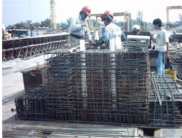
Figura 3.10. Proceso de armado de zapata 2-A
