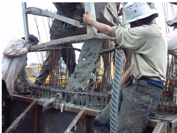
Figura 3.9. Proceso de colado de zapata 1-A
