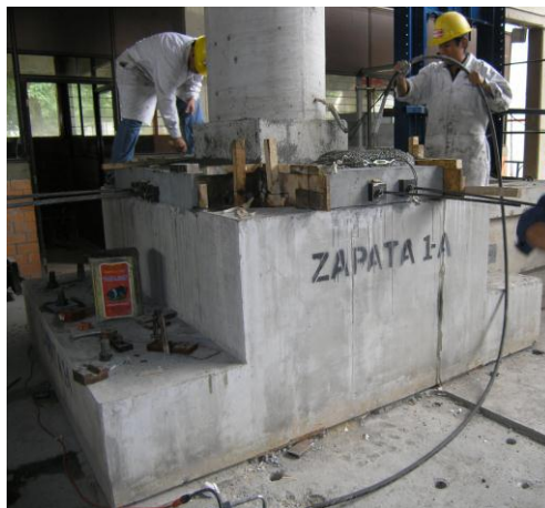
Figura 3.15. Colado de la losa postensada en la conexión cimentación-columna.
