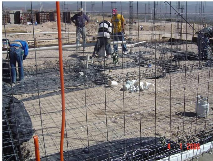
**Figura B.2 Preparación de la losa de cimentación de una vivienda de concreto**
