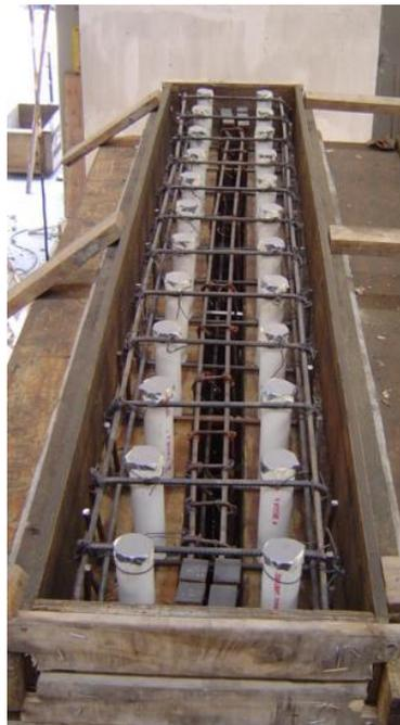
**Figura L.9 Detalle del armado de la losa superior de los muros**
