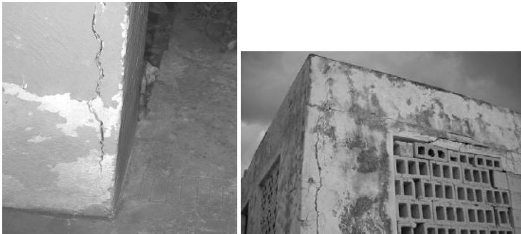
**Figura 2.19 Agrietamientos por corrosión del acero de refuerzo en viviendas (Solís et al., 2005)**
