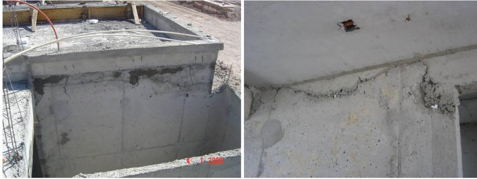
**Figura C.2 Detallado deficiente en la interfase losa-muro (continuación)**
