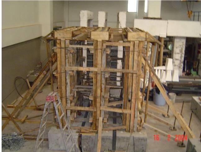
**Figura L.10 Disposición de los muros previa al colado**
