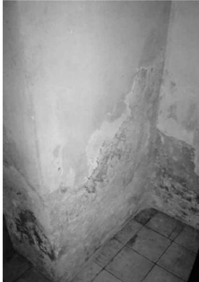
**Figura 2.21 Daños en un muro de concreto por humedad (Solís et al., 2005)**
