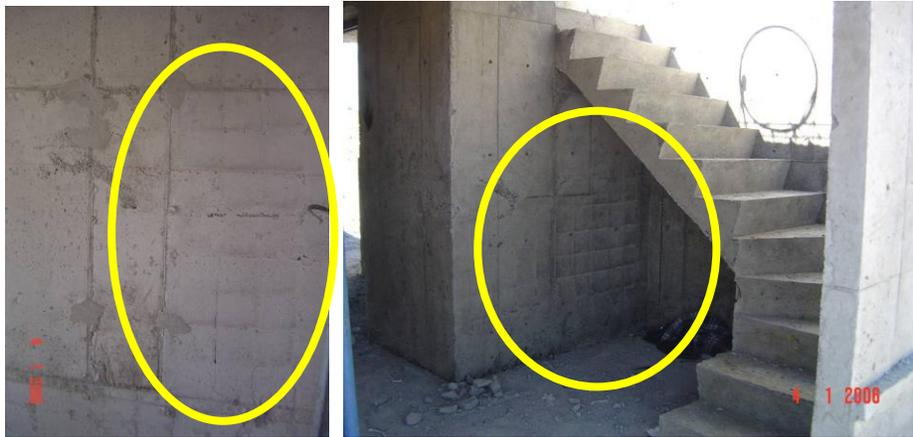
**Figura C.4 Consecuencias de una sujeción deficiente de la malla electrosoldada**
