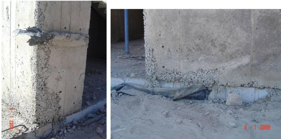
**Figura C.1 Falta de vibrado en las esquinas inferiores de los muros**
