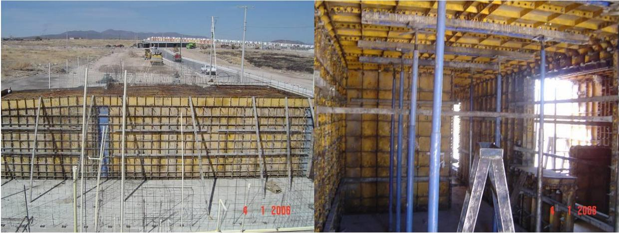
**Figura B.5 Arreglo de la cimbra para el colado monolítico de muros y losa de concreto en viviendas**
