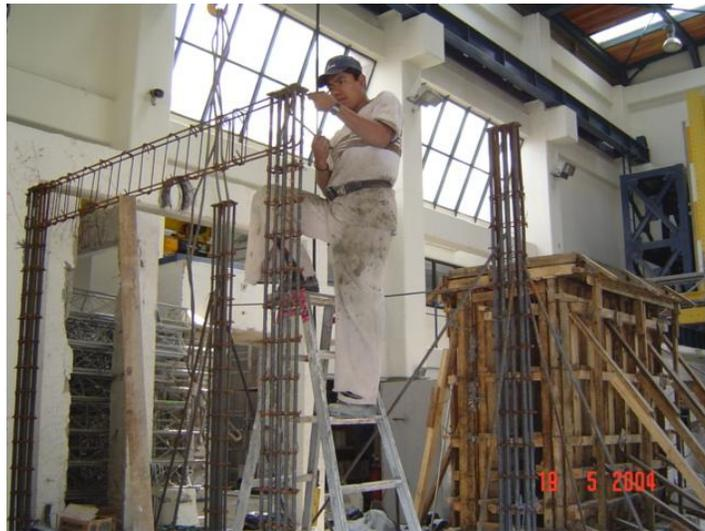
**Figura L.5 Colocación del armado de la viga superior**
