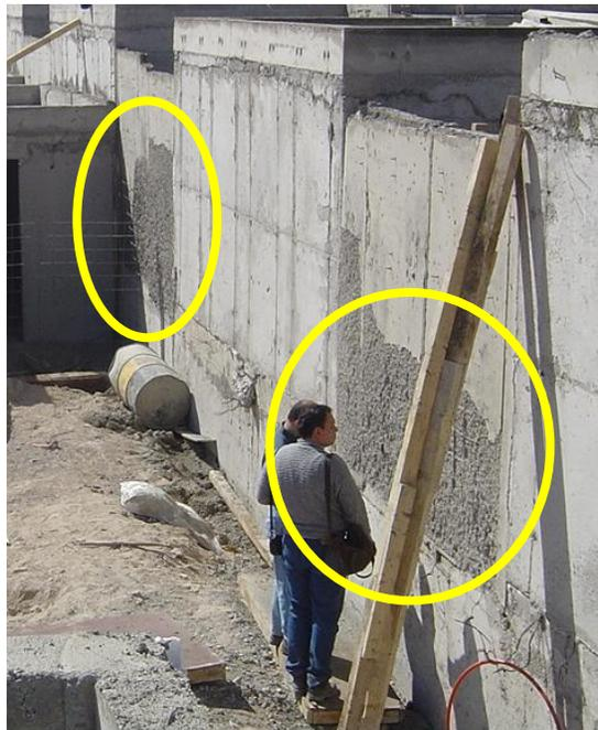
**Figura C.3 Muros de concreto demolidos en su parte inferior**
