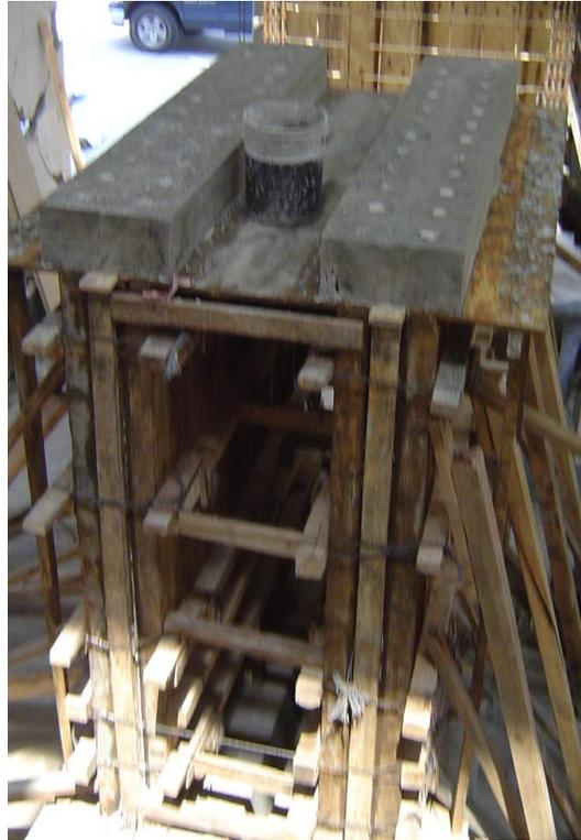
***Figura L.13 Muros de concreto autocompactable***
