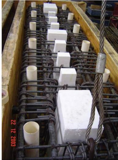
**Figura L.2 Detalle del refuerzo y piezas de poliestireno de una cimentación**
