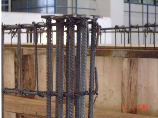
**Figura L.8 Detalle del anclaje mecánico de las barras de refuerzo vertical de los elementos de borde**
