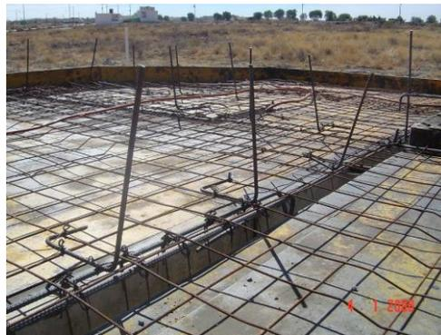
**Figura B.6 Anclajes para dar continuidad a los muros de concreto en viviendas de dos niveles.**
