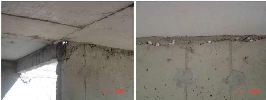
**Figura C.2 Detallado deficiente en la interfase losa-muro**
