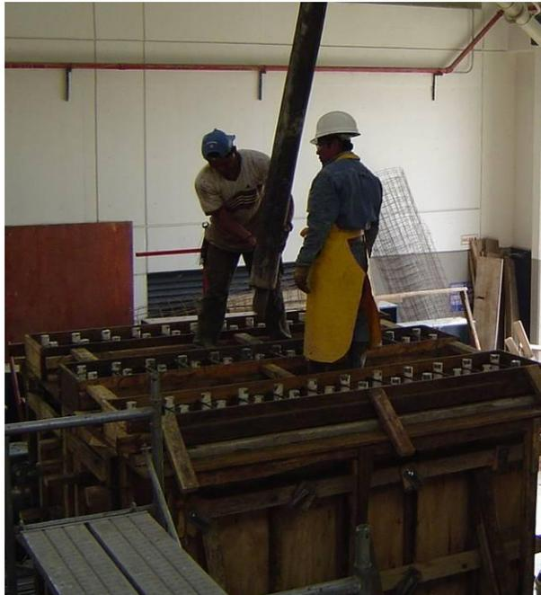
**Figura L.12 Colado de muros de concreto celular**
