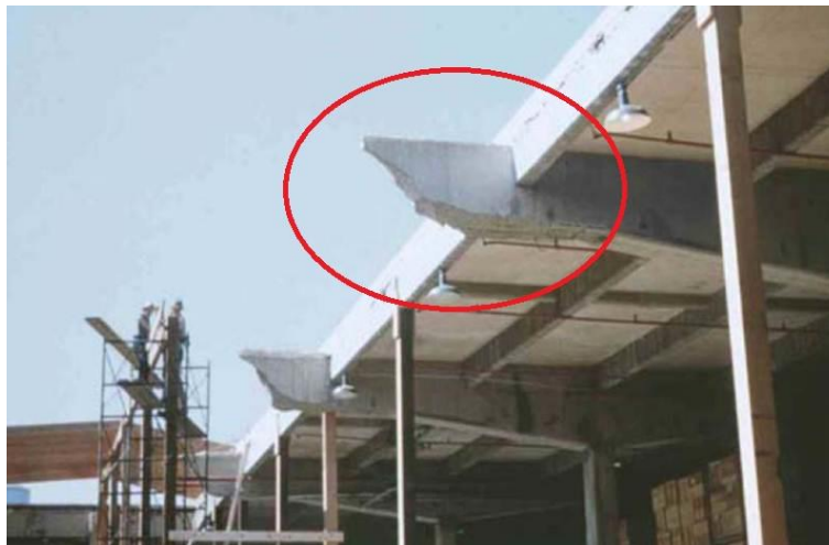
Figura 2.4 Falla por cortante en traves acarteladas ocurrida en Estados Unidos a mediados del siglo pasado (tomada de Collins et al. 2007)
