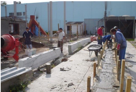
e) colocación del concreto
