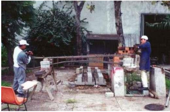
a) habilitado del refuerzo
