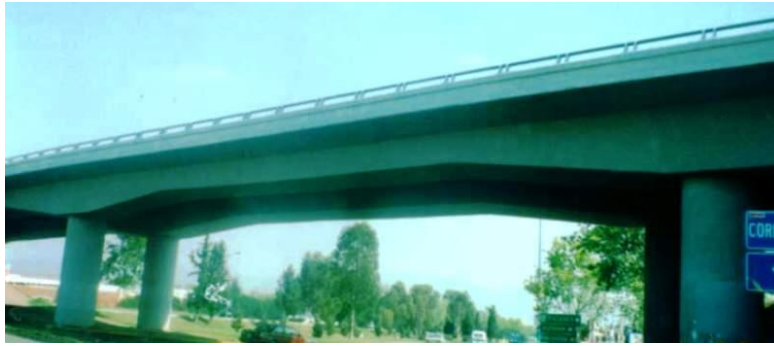
Figura 2.3 Puente carretero con traves acarteladas de concreto reforzado (Estado de Hidalgo)
