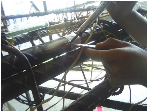
c) conexión cable- strain gage
