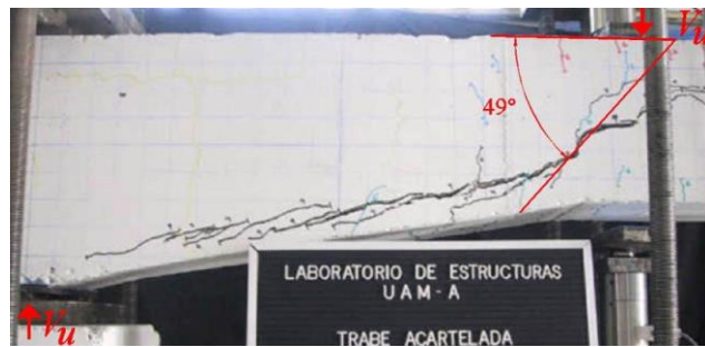
b) grieta crítica carga gravitacional
