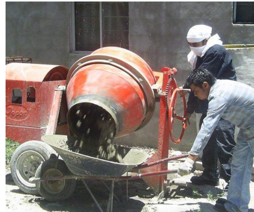
d) elaboración del concreto
