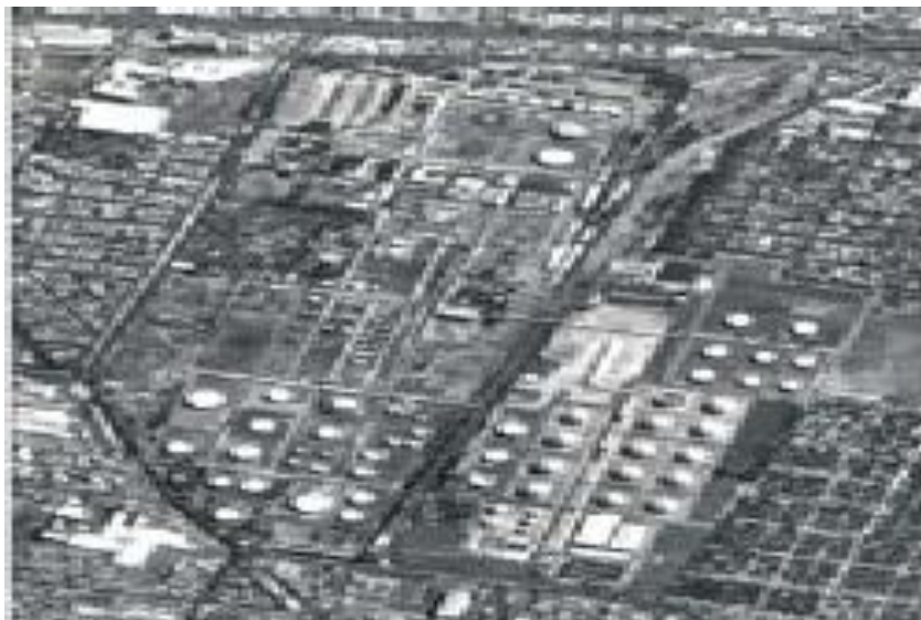
Figura 4.18 Instalaciones de la Refinería 18 de Marzo a su cierre en 1991 Fuente: PEMEX, 2008
