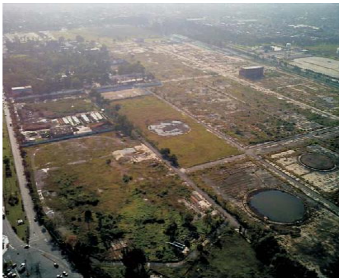
Figura 4.25 Vista de la Refinería 18 de Marzo después del desmantelamiento. Fuente: PEMEX, 2008
