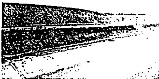
Foto 26. Margen derecha del C.P. Humaya. Nótese en el corte de la excavación la presencia del estrato arcilloso superficial de color oscuro.
