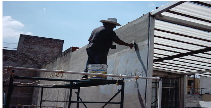
Figura 73 Aplicación de placa durock y posteriormente cemento [38].
