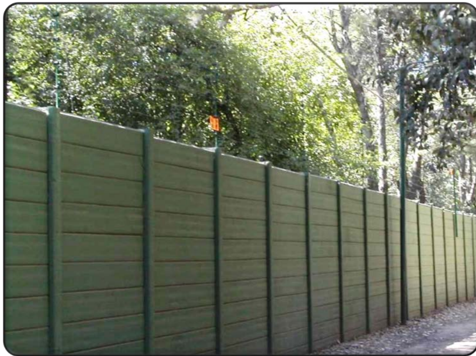
Fig. 3.11. Aplicación del BLOK en cercos.
