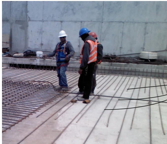
Armado lecho inferior losa de cimentación
