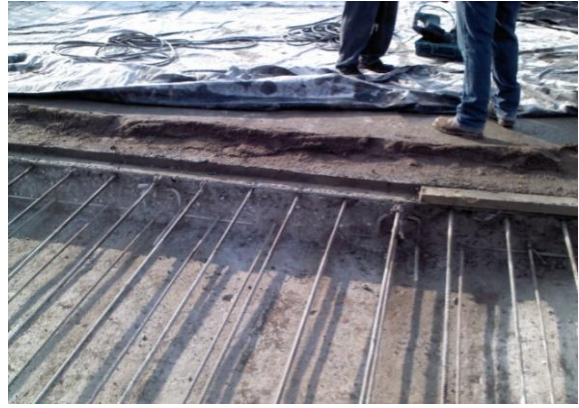
Colado de losa de cimentación hasta junta de contracción
