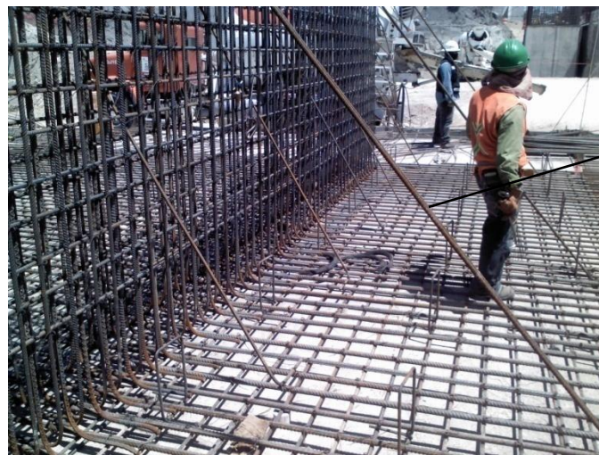
Armado vertical de acero en muros
