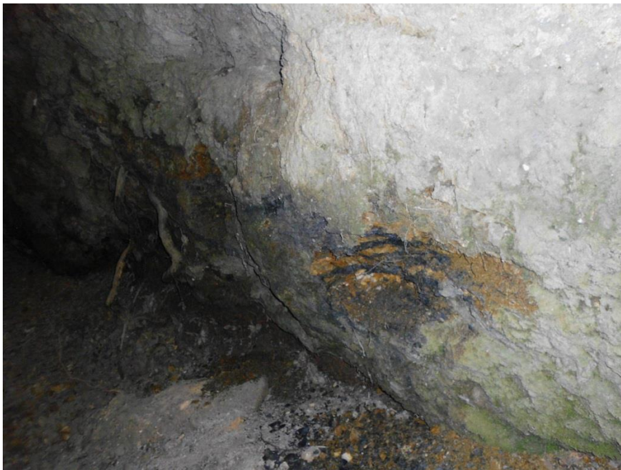
Fotografía 35: Detalle de una de las paredes de la mina donde se puede apreciar la oxidación que presenta junto con las vetas de cuarzo
