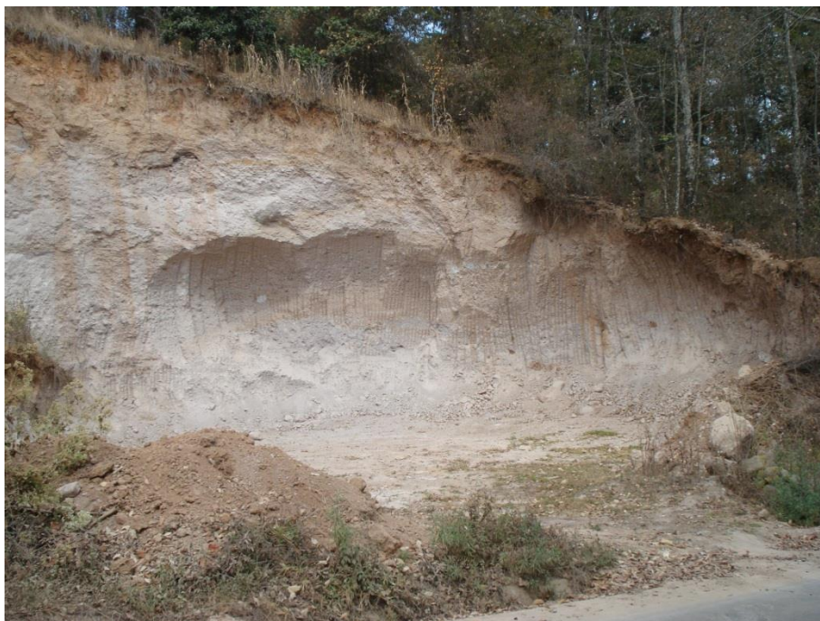
Fotografía 108: Banco a pie de carretera donde se puede observar la explotación mal planeada del banco.
