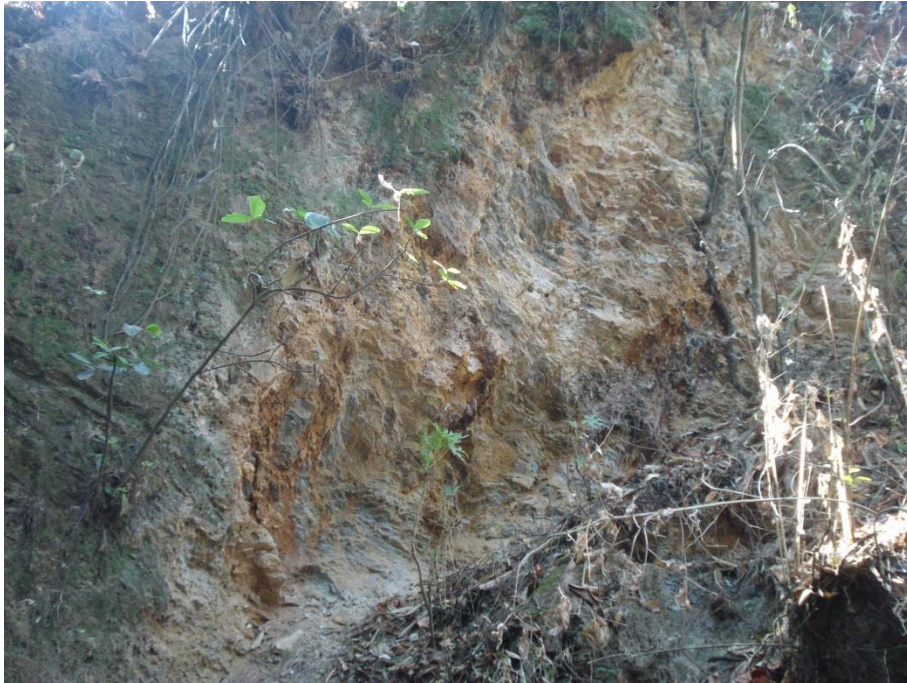
Fotografía 32: Parte trasera de la mina el Tecolote donde se puede apreciar la alteración de la roca.
