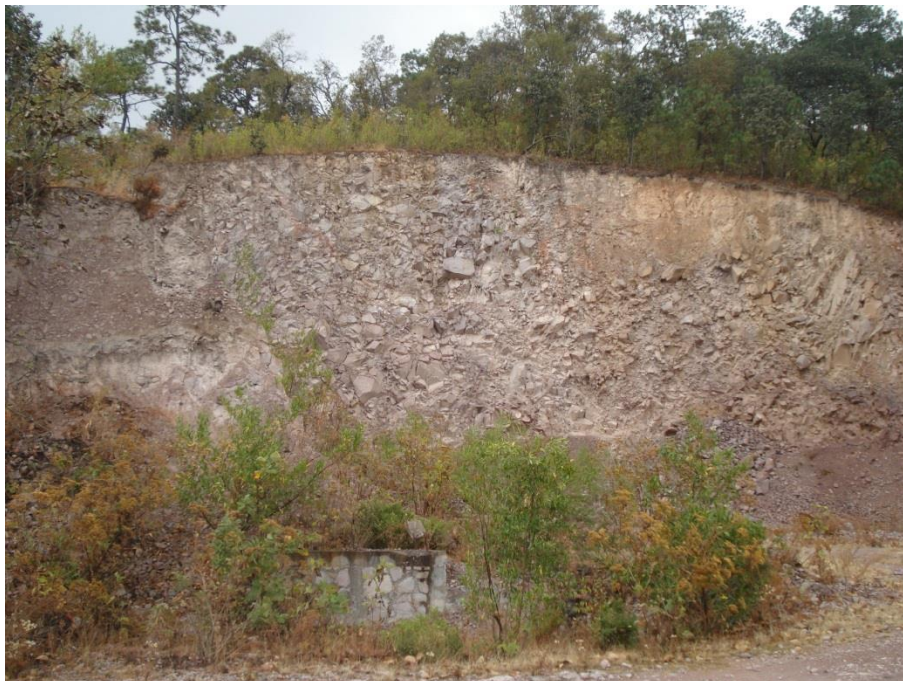
Fotografía 81: Vista del cuarto banco de riolita de Tres Cruces municipio de Zacualpan actualmente cerrado por ordenes del Delegado de la comunidad
