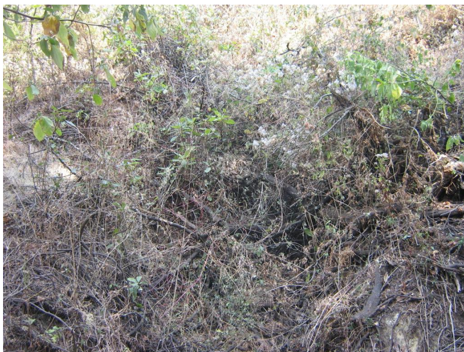
Fotografía 64: Mina la Química totalmente cerrada.
