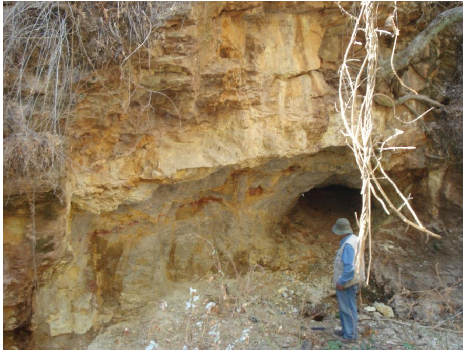
Fotografía 4: Afloramiento de los Arroyos 2 donde se observa la oxidación que presenta junto a la entrada del socavón
