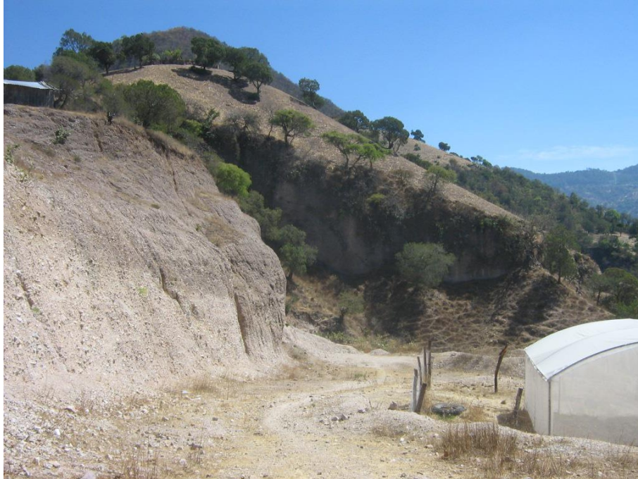
Fotografía 115: Banco Tepehuaje donde se observa la poca explotación que ha sufrido el banco.
