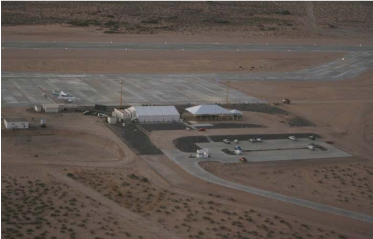
Figura 30. Aeropuerto del mar de Cortes, (Gobierno del estado de Sonora)
