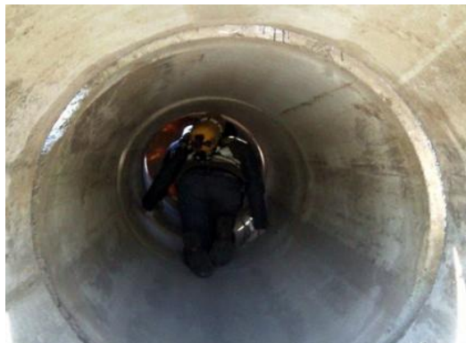
Ilustración 2: Tuberías y ductos
