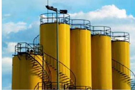
Ilustración 1: Tanques de Almacenamiento
