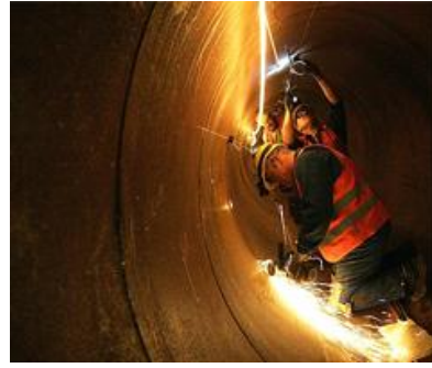
Ilustración 10: Trabajos en Caliente
