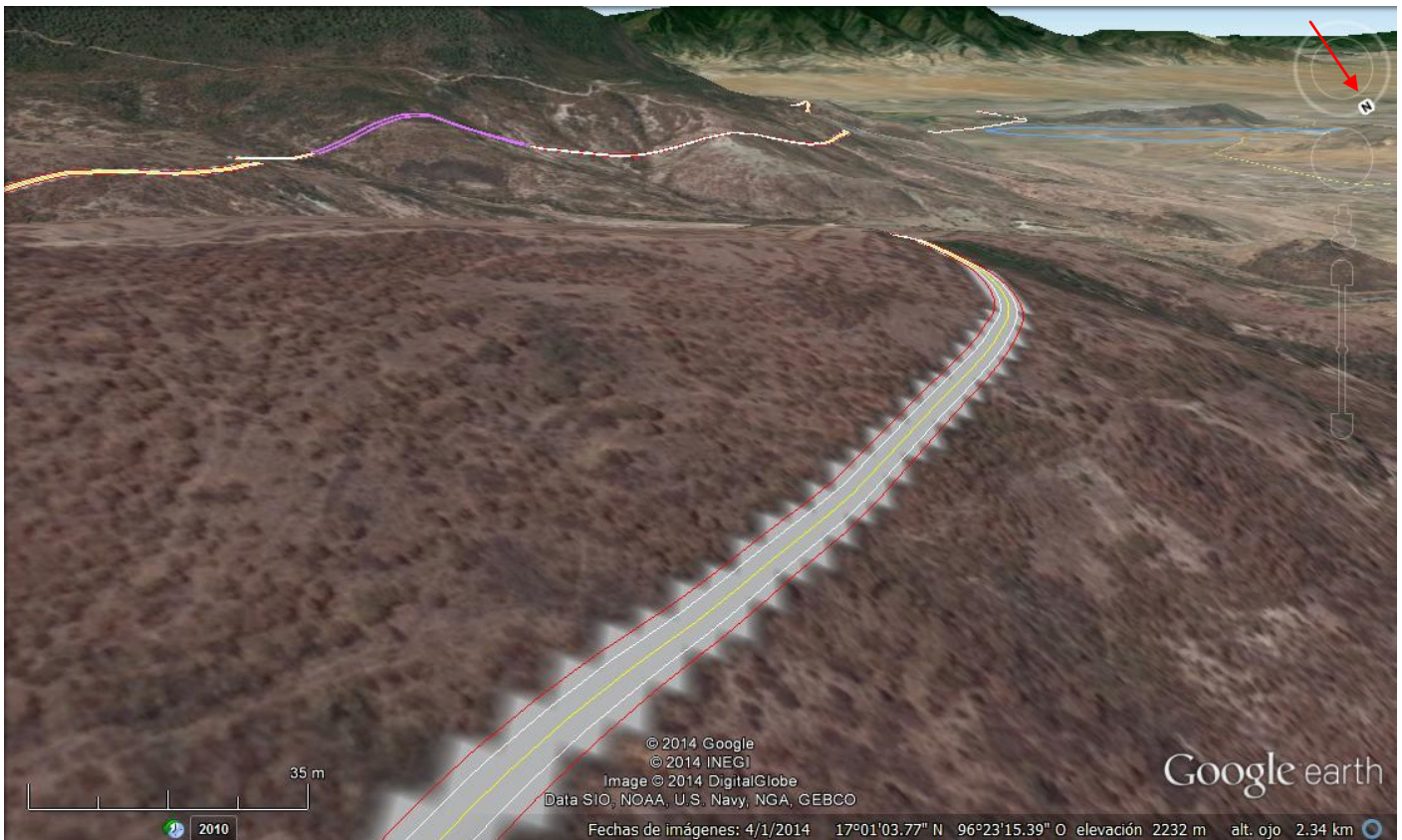
Figura 5.21: Observación de la supercarretera abandonando los Valles Centrales para entrar a la Sierra Juárez (Google Earth).
