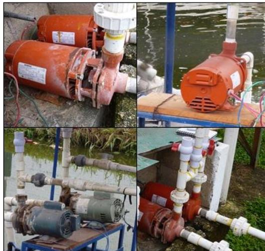
Figura 3.11 Fotografía de las bombas de agua utilizadas en el módulo de producción acuícola del CEIEGT, sus características eléctricas se detallan en la tabla 4.1
